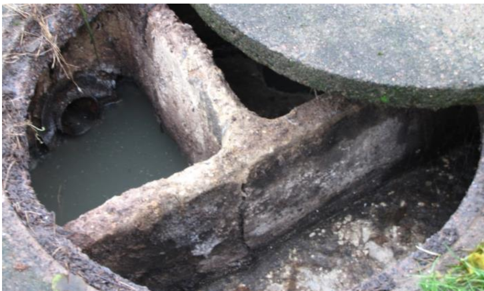
Tillsynsarbetet med de små avloppen behöver anpassas till de lokala förhållandena.
