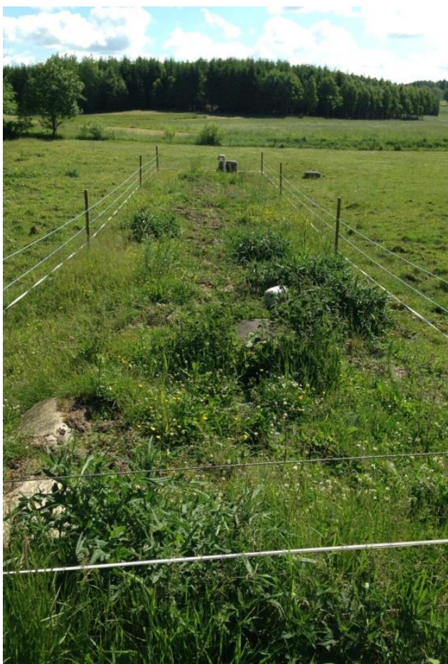
Markbädden har hägnats in för att förhindra att djuren belastar ytan.
