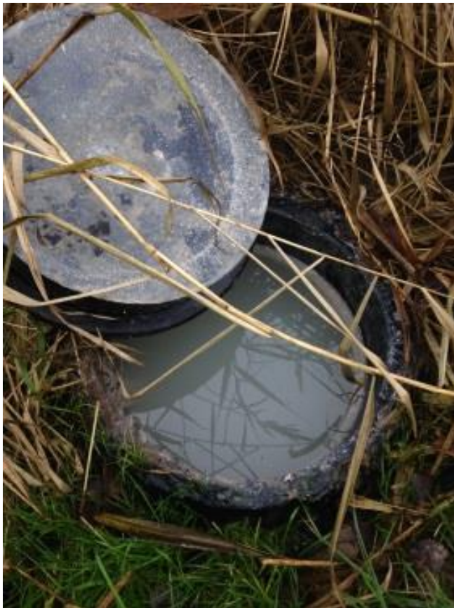
Vattenfylld fördelningsbrunn.
