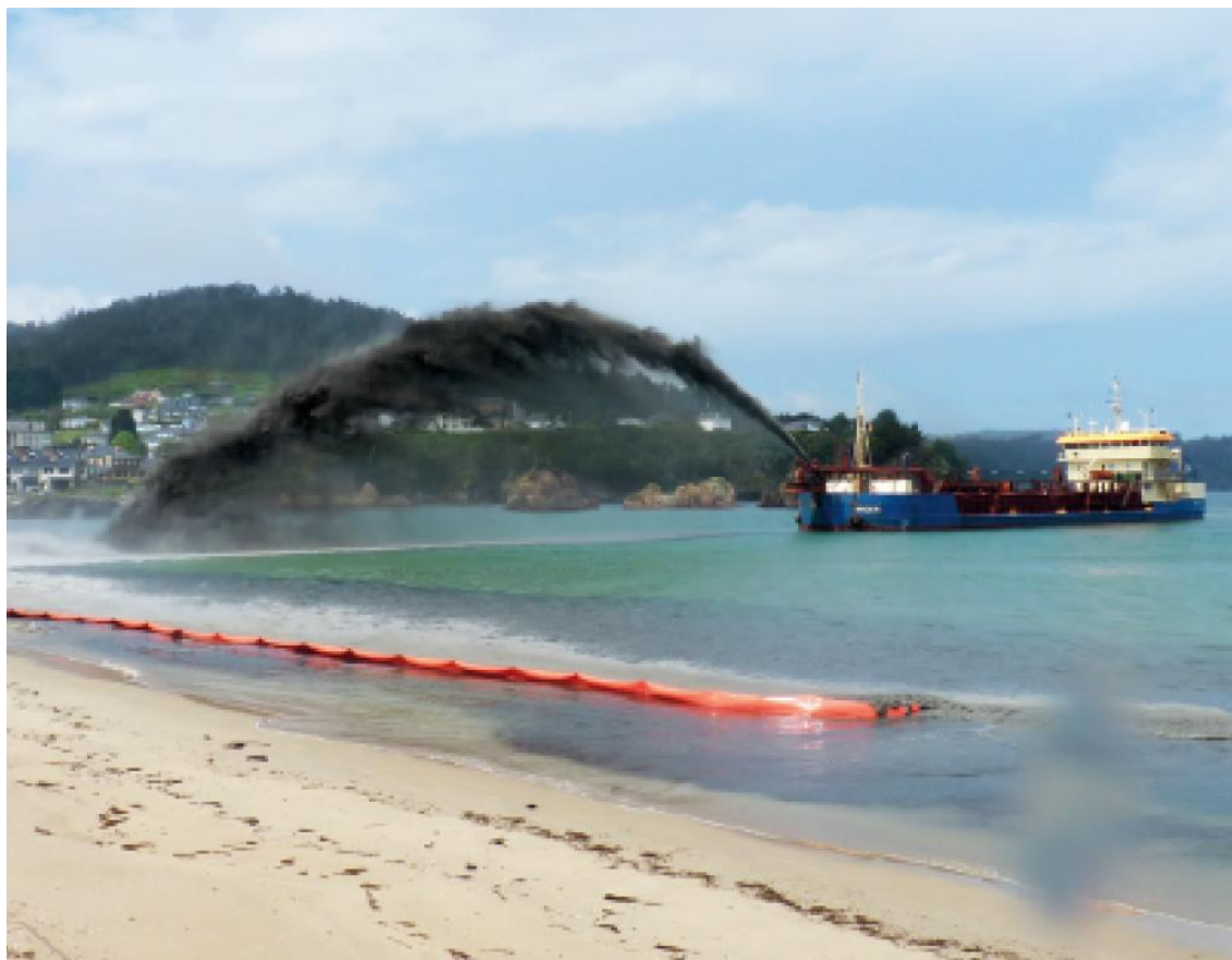
Figur 6. Strandfodring med rainbowing-metod där sand blandat med vatten sprutas från mudderverket (Bild från Rohde Nielsen 2020).
