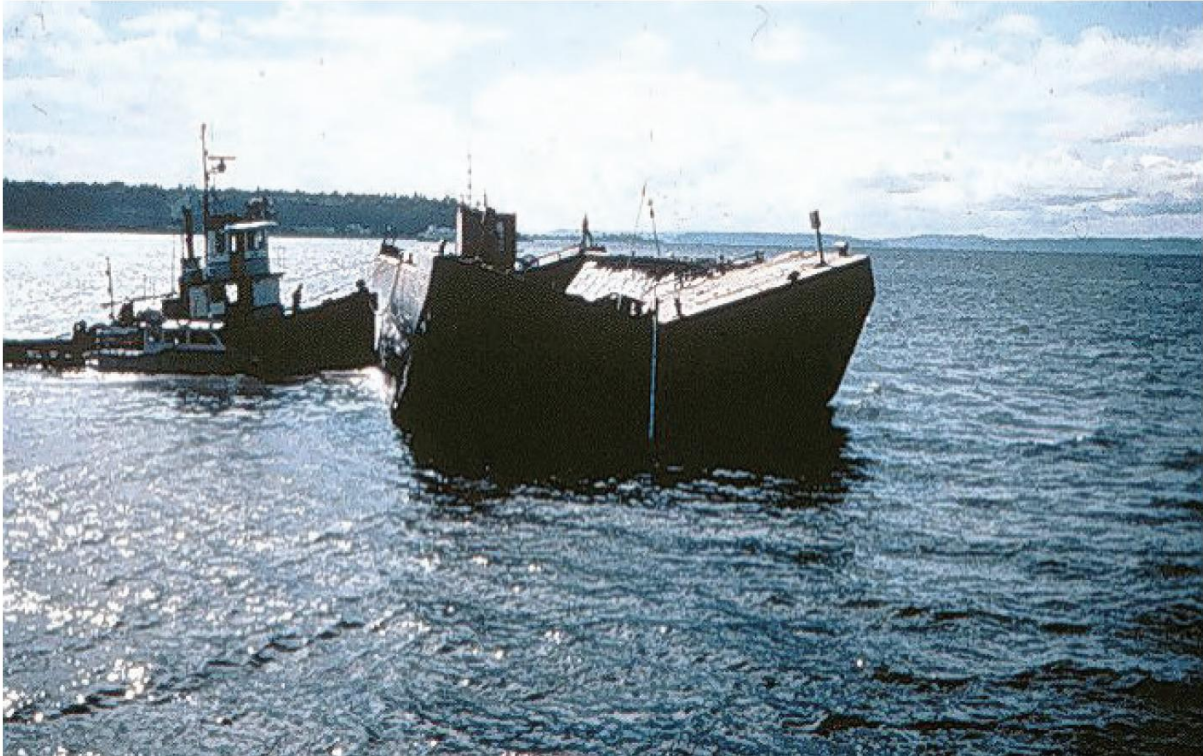
Figur 3. Exempel på sandtäckning med bottentömmande pråm dragen av bogserbåt (bild från Bailey m.fl. 2005).
