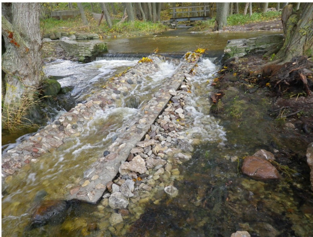
Figur 17. Rännen av betong och natursten som anlades oktober 2012 i Lummelundaån, Gotland för att möjliggöra vandring för flodnejonöga. I maj 2013 noterades flodnejonöga uppströms det tidigare vandringshindret. Foto: Lars Vallin.
