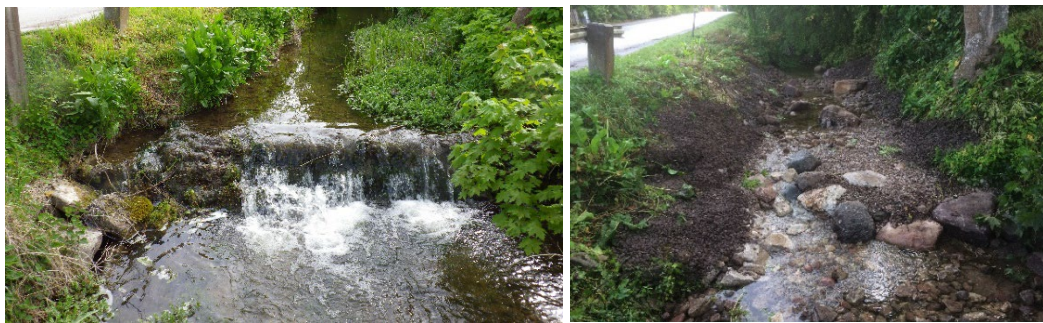
Figur 18. Före och efter åtgärd i Robbjänsån, Klintehamn, Gotland. Foto: Lars Vallin.
