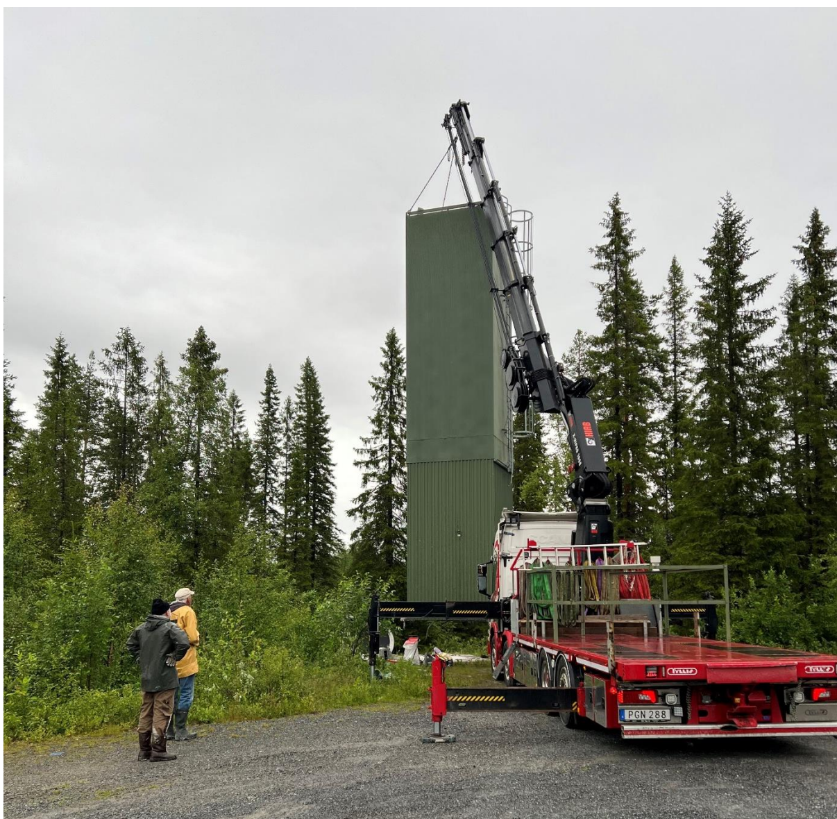
Kalkdoseraren i Stamsjöån demonteras för vidare flytt till Fällforsån. Foto: Ulf Olofsson.
