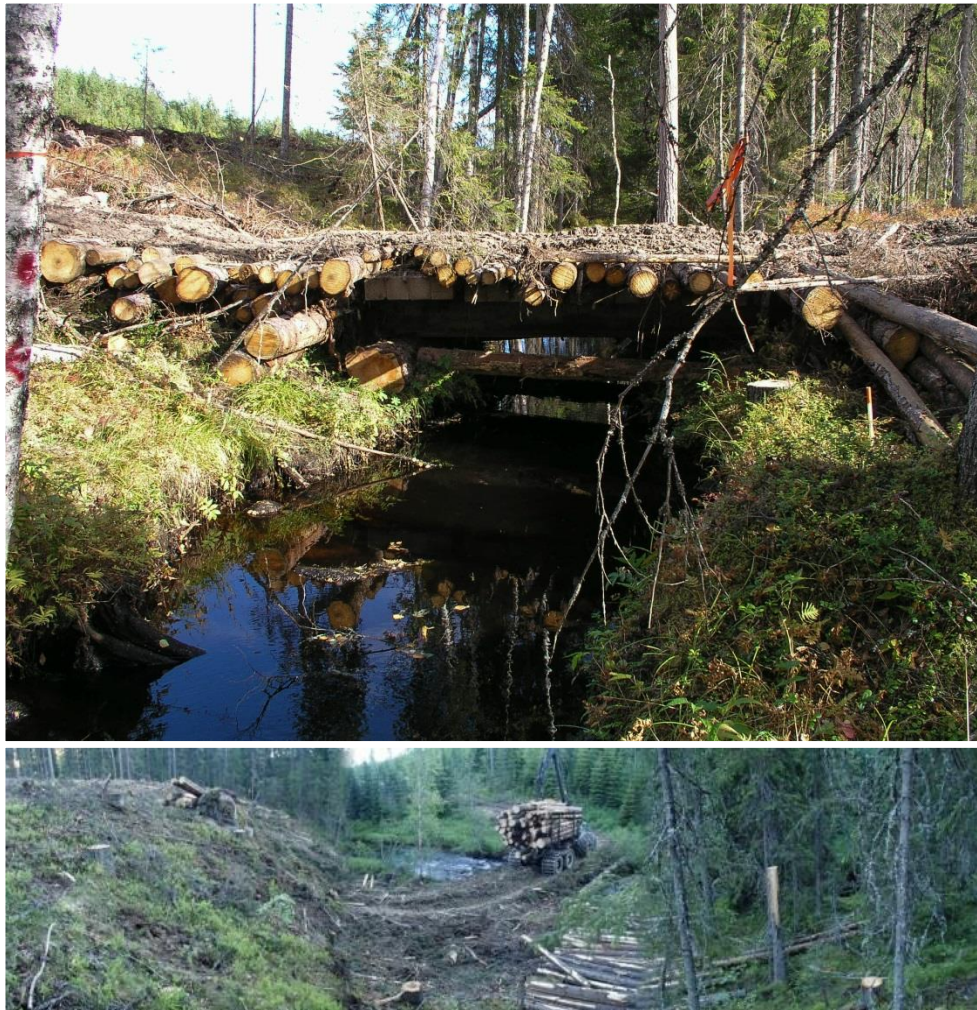
Figur 27. Exempel på god vattenhänsyn i skogsbruket – tillfälliga broar för virkestransport. Broarna förhindrar direkta skador på musselvattnen Börkelån (övre bilden) och Hemgravsån, Västerbottens län (undre bilden), och minskar även risk för slamtillförsel. Foto: Håkan Söderberg.
