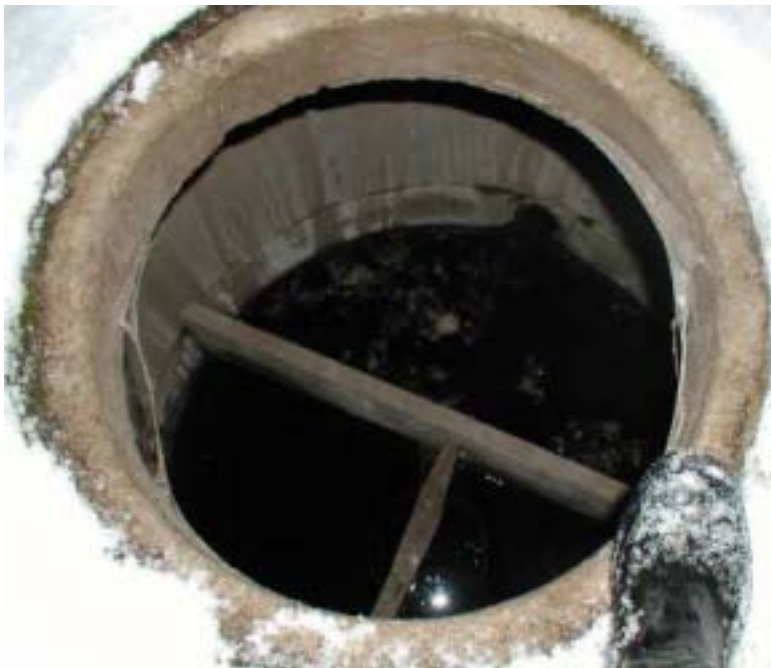
Figur 6. En slamavskiljare i form av en trekammarbrunn.
