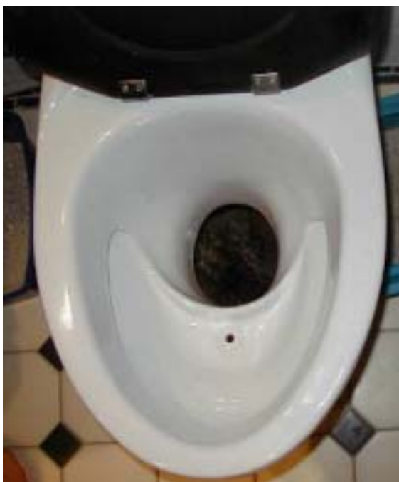
Figur 3. Urinsortande torrtoalett av porslin.
