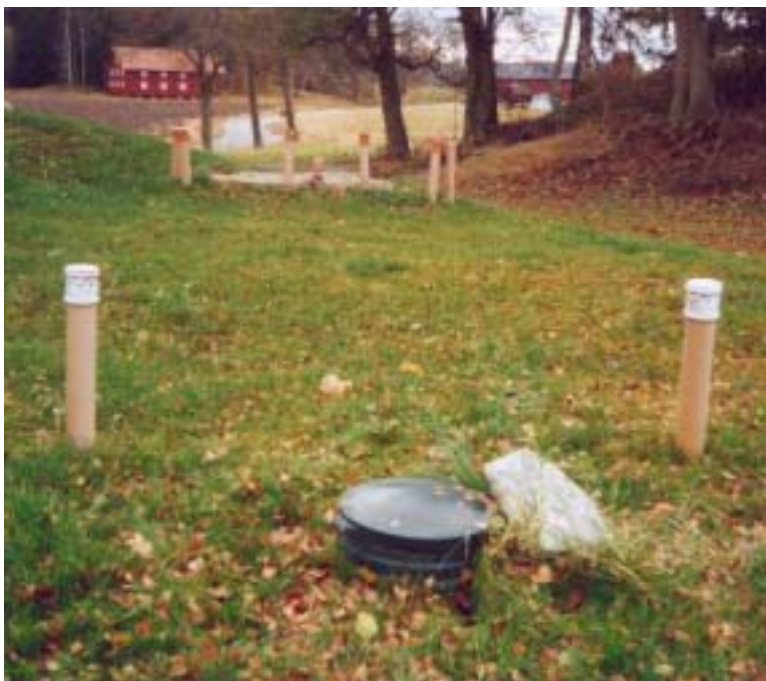
Figur 9. Traditionell markbädd försedd med extra rör för provtagning och inspektion.
