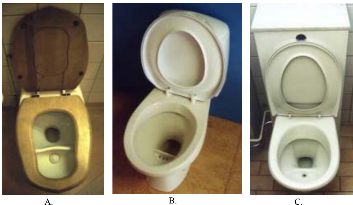
Figur 5. Olika modeller av urinsortande vattentoalett. A. Dubbletten B. WostManEcology C. Gustavsberg.
