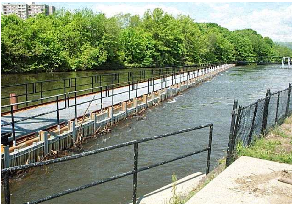
Figur 13. Louver-system från Holyoke, Massachusetts, USA. Bilden är tagen ungefär vid öppningen till förbypassagen för fisk. Man ser också all bråte som samlats vid gallret.
