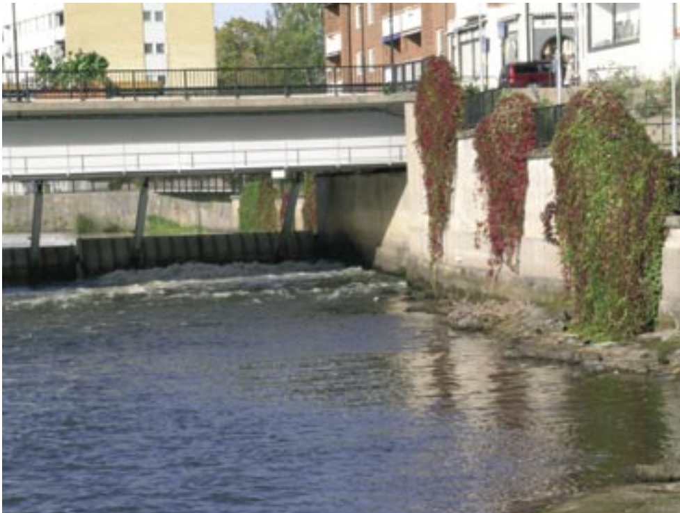
Byälven - Damm (Lokal 46) 2003-09-25.
