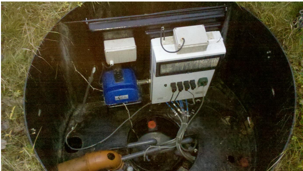
Så här ser anläggningen ut när den inte fungerar bra. Kemikalier saknas.
