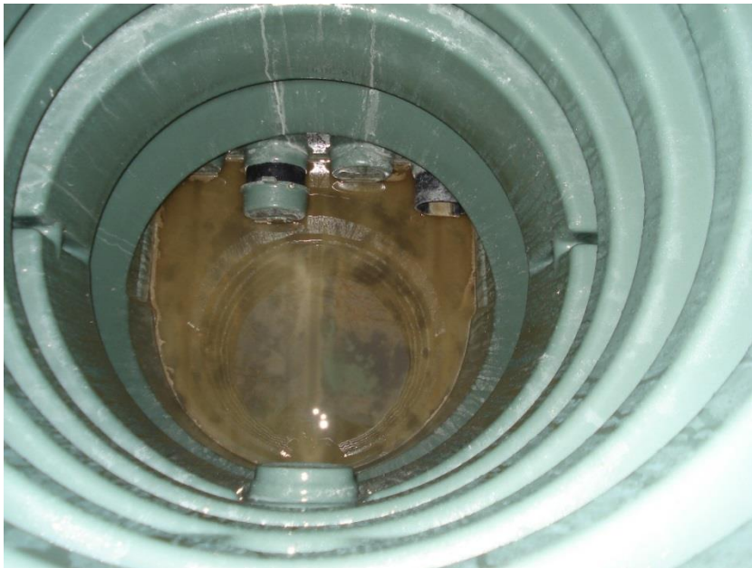
Figur 4: Felaktig installation av utlopp i en fördelningsbrunn som leder ut vatten till två biobäddar. Det ena utloppet är öppet medan det andra har ett lock med ett mindre hål i. Den ena biobädden kommer att belastas med mer vatten än den andra.
