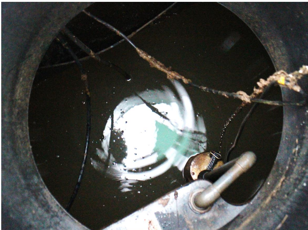
Bild 5 Så här ser anläggningen ut när det inte fungerar bra, grumligt vatten, slam på väggar
