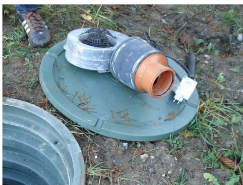
Figur 2: Fläkten lyfts loss inför provtagning.
