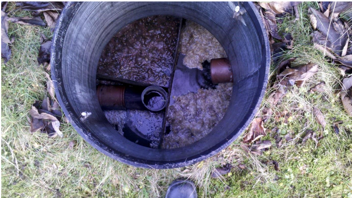
Kontroll av slamavskiljare före verket.
