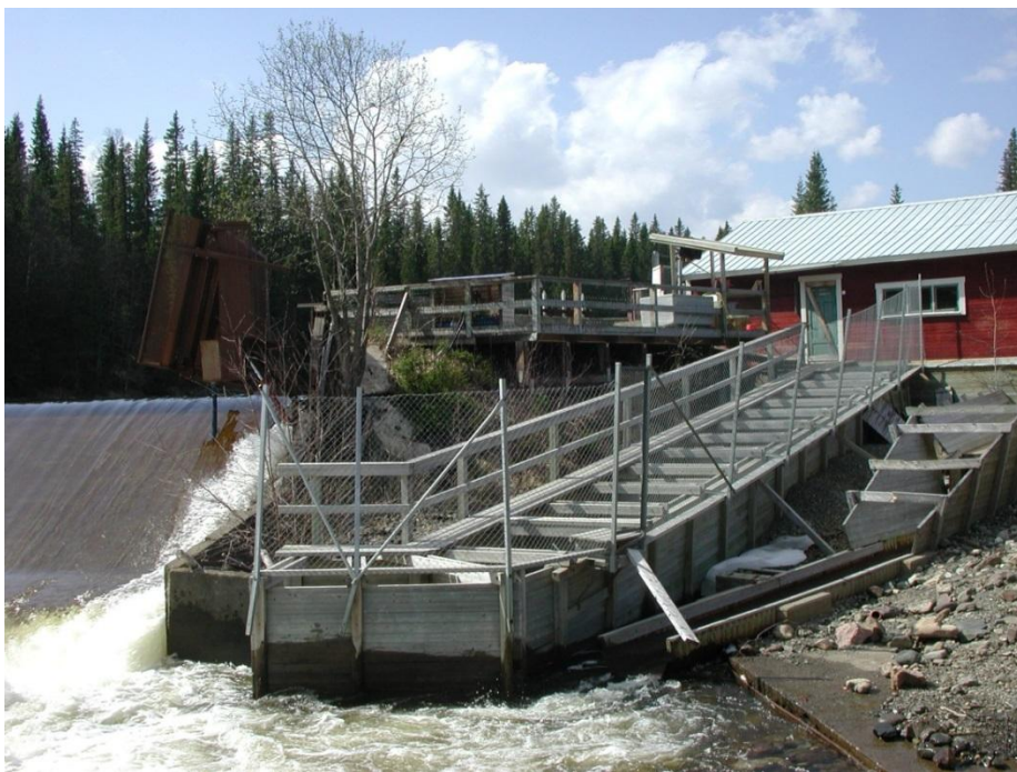
Figur 16. Fisktrappan vid Åhns kraftverk i Dammån, Indalsälven. Foto: Ingemar Näslund.
