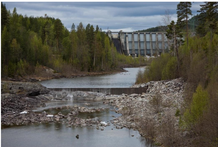
Figur 15. Grunddamm i Faxälven nedströms Ramsele kraftverk. Foto: Ingemar Näslund.
