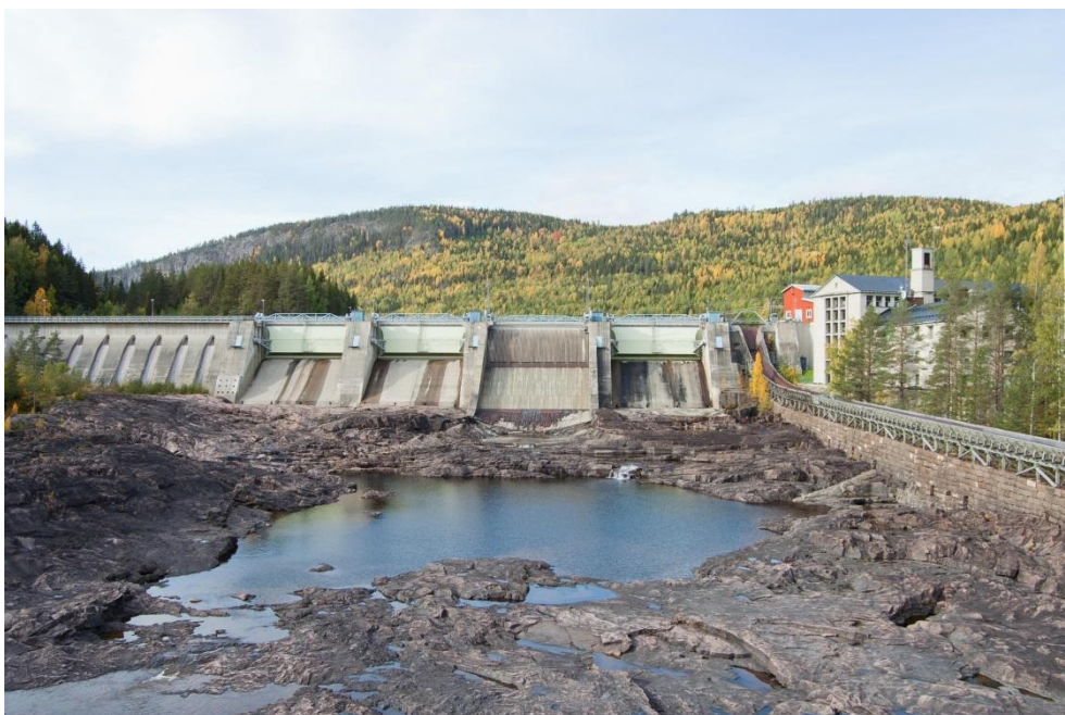
Figur 7. Krångede kraftverk (Indalsälven) med betongdamm. Anlagt 1936. Foto: Ingemar Näslund.
