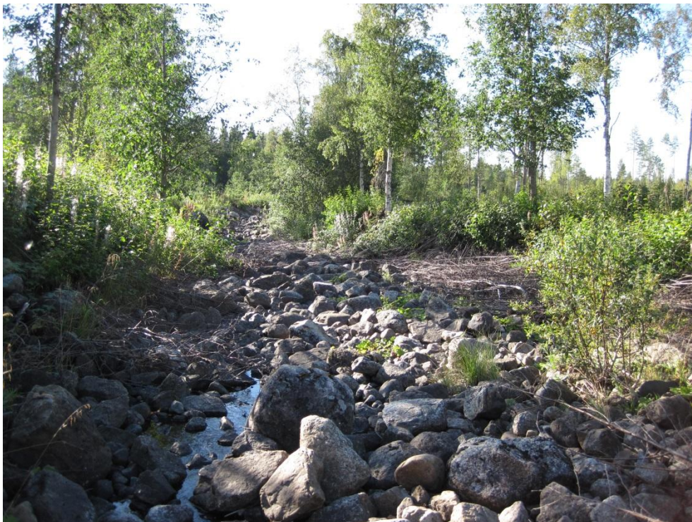
Figur 26. Även vid småskaliga kraftverk torrläggs vattendragssträckor. Här torrfåran nedströms Hunge kraftverk i Gimåns vattensystem. Foto: Ingemar Näslund.
