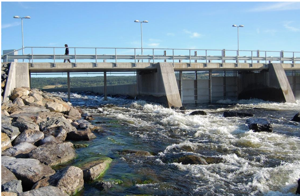
Figur 17. Inlöp genom sjön Hotagens regleringsdamm (Hårkan, Indalsälven). Foto: Ingemar Näslund.
