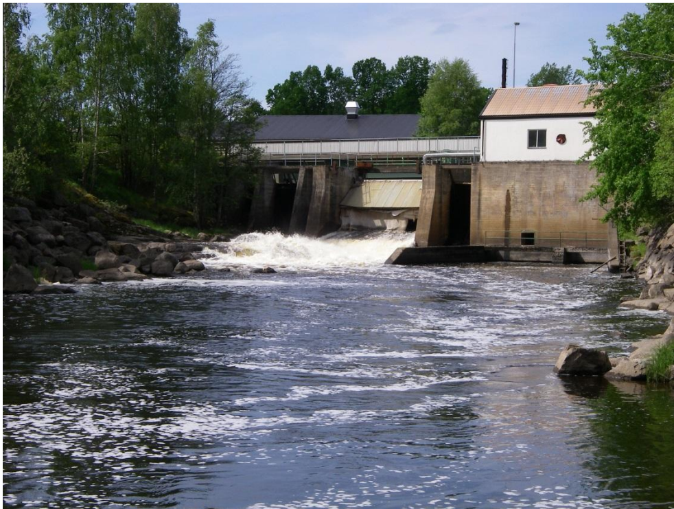
Figur 8. Kraftverket vid Järnforsen i Emån, byggt i direkt anslutning till dammen. Foto: Jakob Bergengren.
