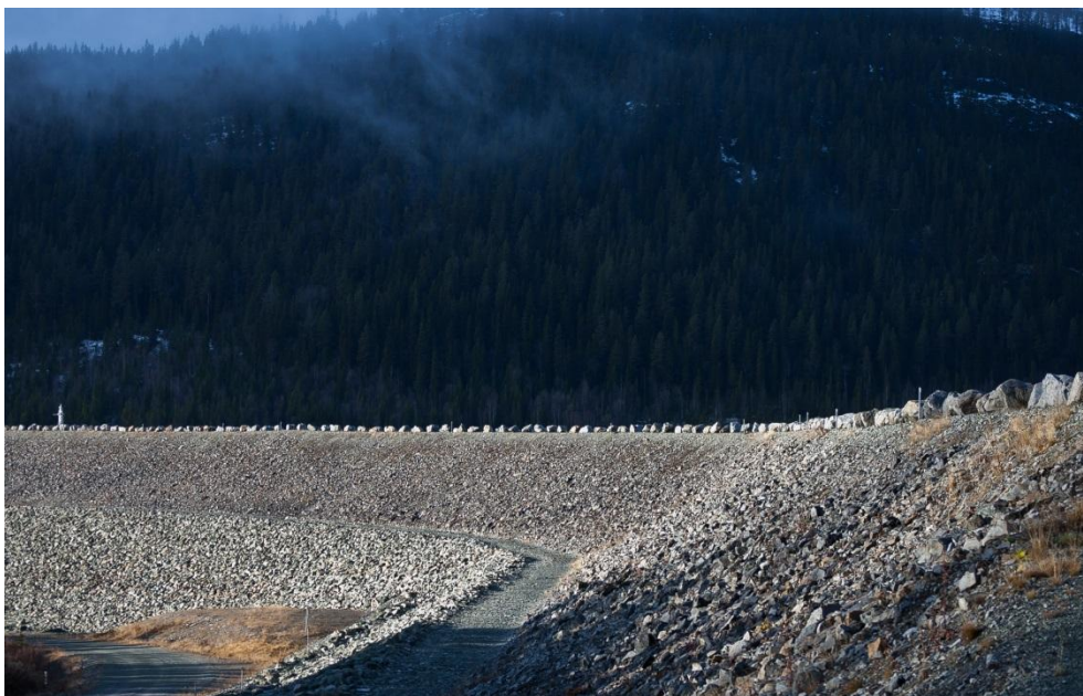
Figur 6. Flåsjödammen i övre delen av Ljungan. Exempel på fyllningsdamm. Foto: Ingemar Näslund.
