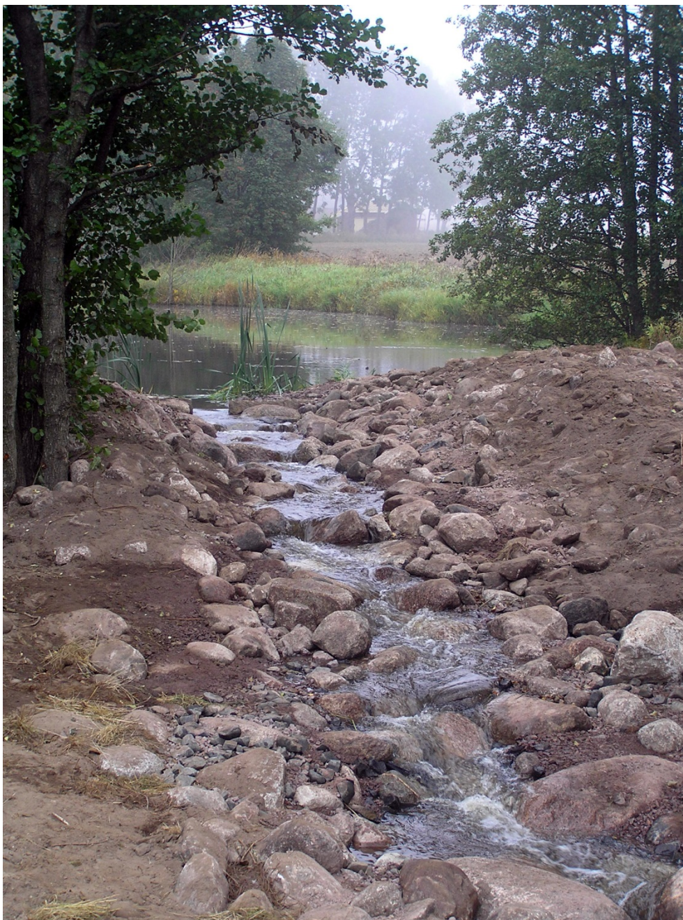
Figur 5. Rocky ramp, eller upptröskling, i Sjörydsbäcken, Hjo kommun. Bäckfåran nedströms dammen har "lyfts upp" till dammens kant. Fåran har en V-profil för att fungera för fiskvandring både vid låg- och högvatten. Foto Erik Degerman.
