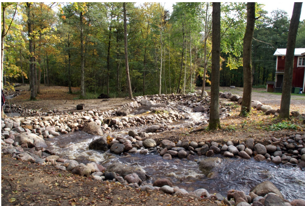
Figur 6. Del av det flera hundra meter långa omlöpet i Knipån, Habo kommun, som gör att öring från Vättern kan nå sina tidigare lekplatser. Foto Erik Degerman.
