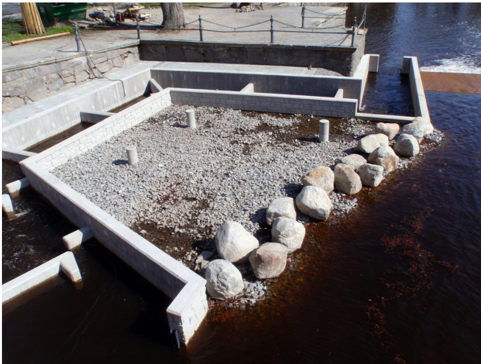
Figur 9. Slitsränna vid Slotten i Örebro, Svartån. Vyn är nedströms. Genom de smala slitsarna skall fisk vandra. Funktionskontroller har visat att bland annat benlöjor passerar fiskvägen som är en passage runt låga dämmen (skibord) mitt inne i Örebro. Foto Erik Degerman.
