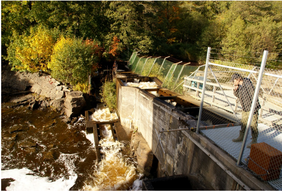
Figur 10. Denilrännan vid Herting, Falkenberg, i Ätran. Fisk anlockas av det turbulenta utflödet från fiskvägen som förstärks ytterligare av ett separat utskov för attraktionsvatten som mynnar mitt emot fiskvägsingången (Calles m.fl. 2012). Fisken kan vid behov utnyttja tre vilobassänger. Foto Erik Degerman.
