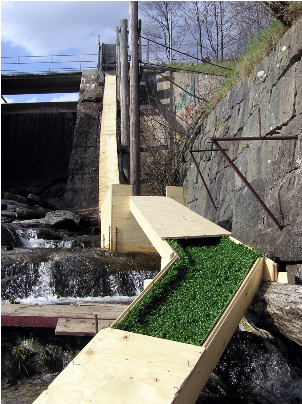
Figur 16. Ålledare med "konstgräs" under konstruktion vid Hedefors i Sävån. Foto Stefan Larsson.
