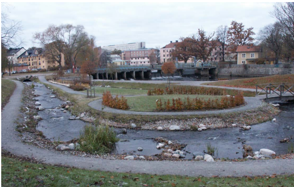
Figur 18. Omlöpet Slussen, Svartån, Örebro. Här återskapades den strömsträcka som för över 100 år sedan försvann när Svartån dämdes och en sluss byggdes 1886. Det är fem km till närmaste strömsträckor uppströms i ån och strax nedströms ligger Hjälmaran. Foto Erik Degerman.
