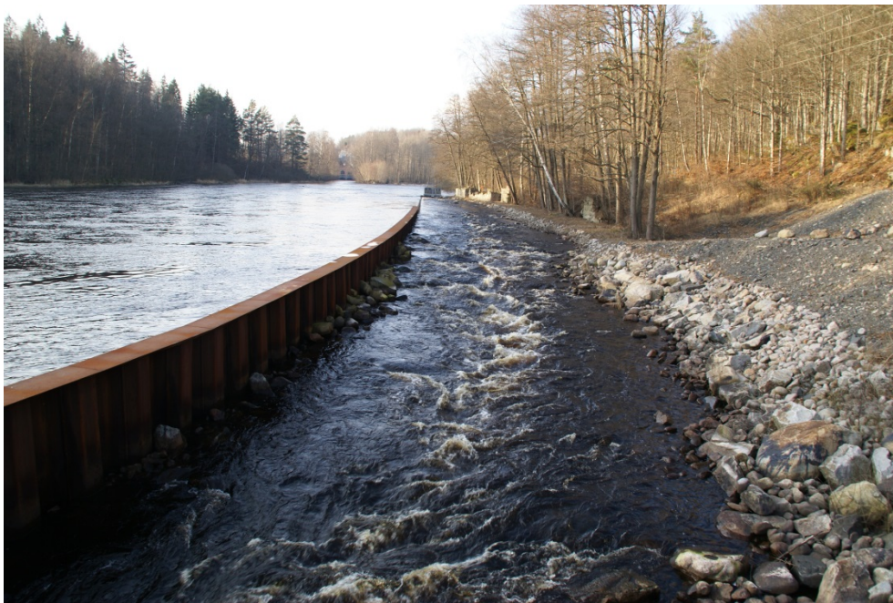
Figur 7. Inlöp vid Hemsjö övre, Mörrumsån. Stålspont gör att vandringsvägen hålls öppen utmed stranden, samtidigt som vandringsvägen fungerar som extra utlopp vid högflöden. Vattenföringen i vandringsvägen regleras av ett utskov i övre delen. Foto Erik Degerman.
