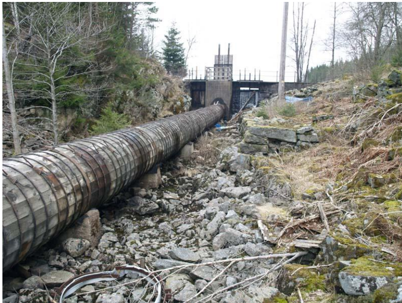
Figur 1 Utloppet ifrån sjön Såken i Äträs avrinningsområde. När vatten leds med tub från dammen till maskinhuset uppstår ofta torrlagda vattendragsträckor. I detta fall leder det till bristande konnektivitet både genom det torrlagda vattendraget. Torrläggning av naturfåran likt bilden förekommer i såväl stora som små vattenkraftverk. Foto: Johan Kling.
