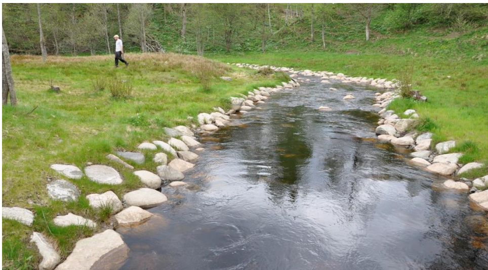
Figur 3 Naturligt omlöp vid ett vattenkraftverk i Rolfsån som i stora delar ger alla de funktioner som förekommer i ett naturligt vattendrag. På sikt kan detta omlöp tillföra delar av de habitat som har gått förlorade i dämningssområdet.
