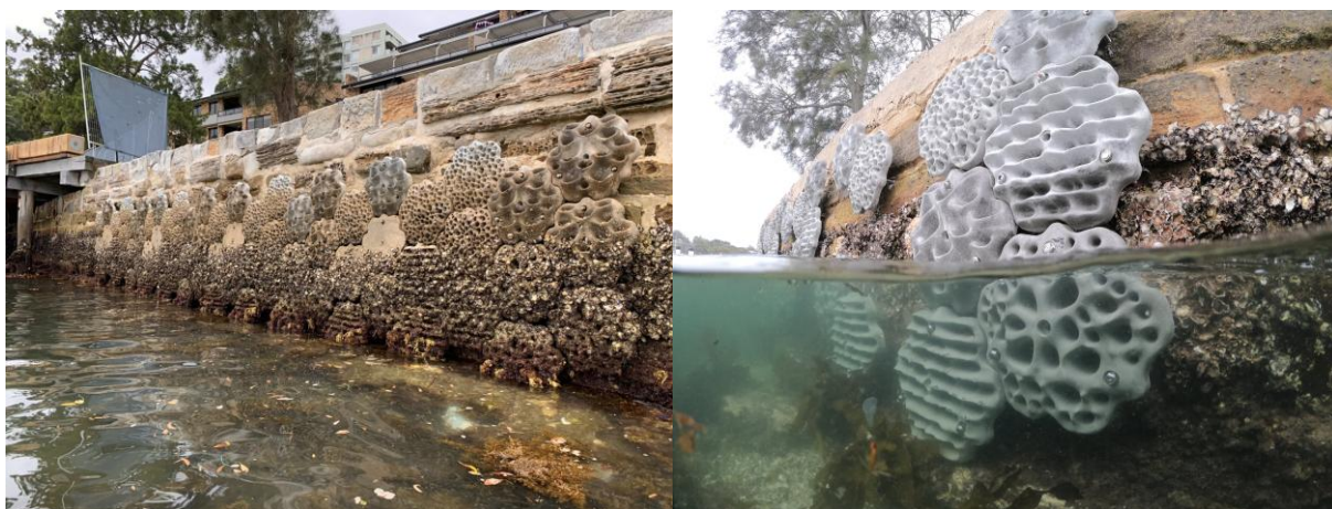
Figur 3 Exempel på externa strukturer som lagts till på en strandskoning för att uppnå ekologisk förbättring genom mer komplex struktur. Bilderna är från Sydney hamn (vänster bild: fotograf Maria Vozzo; höger bild: fotograf Alex Goat). Samma typ av strukturer har också installerats i Sverige, i Oceanhamnen i Helsingborg (Swift 2024).
