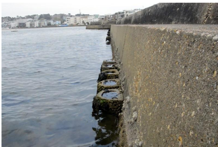
Figur 7 Exempel på ekologisk design med element som efterliknar hållkar, installerad i England. Fotograf Jess Bone.
