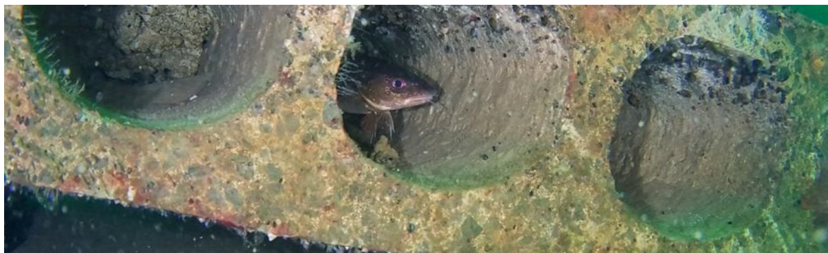
Figur 6 Moduler i betong med "gömmställen". Dessa strukturer har lagts ut i Hanöbukten för att ge skydd och bättre förutsättningar för torsk. Bilden används med Hanö torskrev's tillstånd, https://hanotorskrev.se/index.html .
