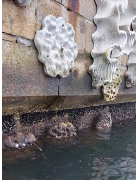
Figur 12 I Helsingborgs Oceanhamn har artificiella strukturer installerats på kajväggen för att ge högre strukturell komplexitet, i syfte att öka den biologiska mångfalden (Swift 2024).
