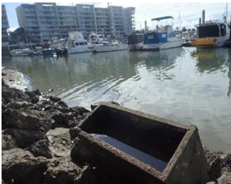
Figur 8 Betonglåda som ska efterlikna effekten av ett hållkar, fäst vid medelvattennivå på en strandskoning i en småbåtshamn i Australien. Från Waltham och Sheaves 2018.
