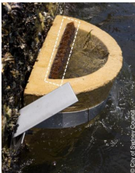
Figur 9 På det här artificiella hållkaret har kokospanel med mjuka fibrer fästs på bakväggen för att ge ytterligare mikrostruktur, fäst på bakväggen. Från en strandskoning i Sydney Hamn, Australien. Den extra åtgärden hade dock liten effekt jämfört med effekten av själva det artificiella hållkaret. Från Morris m.fl. 2018.
