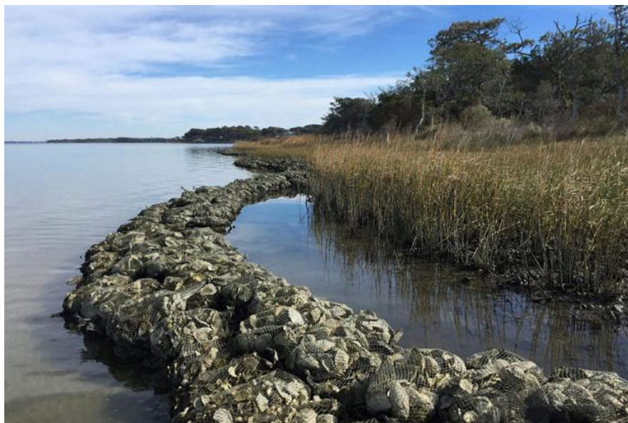
Figur 4 Exempel på en levande strandlinje för naturlig erosionskontroll genom användning av växter och av sten, samtidigt som naturliga kustprocesserna bibehålls. Från: Living shoreline project, Pine Knoll Shores, North Carolina. Fotograf: Rachel Bisesi/North Carolina Coastal Federation. https://www.fisheries.noaa.gov/insight/understanding-living-shorelines .
