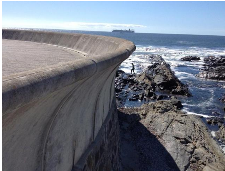
Figur 1 Exempel på en traditionell strandskoning för kustskydd, med slät yta utan ekologisk design. Från Schonees m.fl. 2014.
