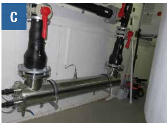
Figur.18. Utrustning för vattenbehandling i RAS anläggning. (A) Proteinskummare tar bort löst organiskt material (B) I rörligt biofilter (MBBR) växer bakterier som biofilm på ytförstorande substrat (här plastbollar). Biofilmen får stor yta mot vattnet och bryter ner och renar vattnet från kvävehaltiga (och för odlingsorganismerna giftiga) ämnen i vattnet. (C) Desinficering. Vattnet passerar en lampa med UV-ljus på 254 nm våglängd för att ta bort virus, bakterier, svamp och parasiter. (D) Syresättning av vattnet. I en syrekon tillsätts ren syrgas via tryck till vattnet.
