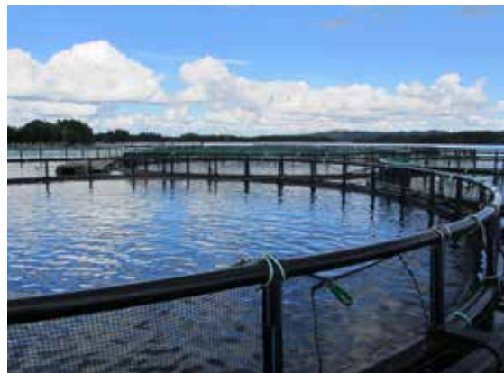
Figur 3. Principskisser över kassodlingar. Konstruktionen består av förankring, flytkonstruktion och en nätkasse.
