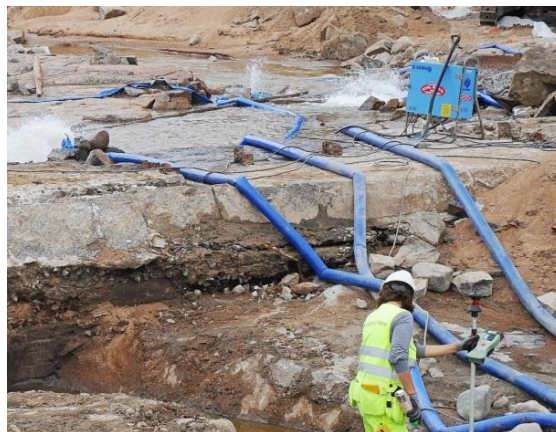
Bild 8. Fundament till gammal kvarndamm
