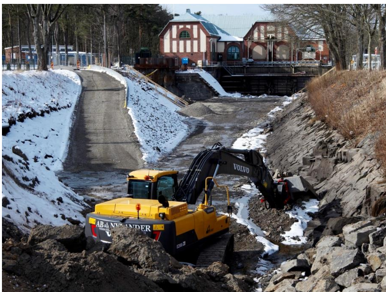
Bild 1. Inloppkanalen till H1 förbereds för det nya gallret.
