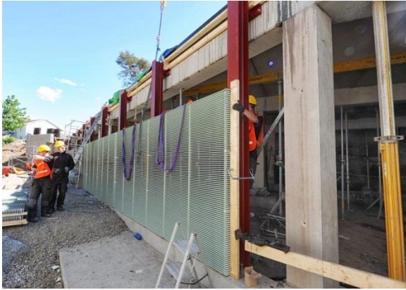
Bild 4. Montering av det nya gallret vid H1
