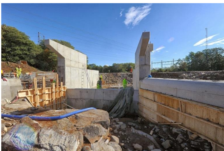
Bild 9. Konstruktion av kontrollstation och överfallsdammar
