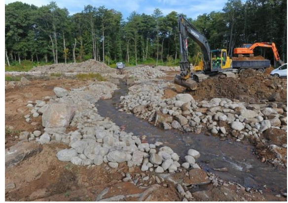
Bild 12. Arbete med den nya fiskvägen
