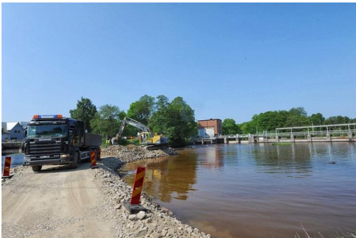
Bild 6. Invallning av befintlig damm
