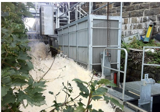
Bild 17. Fisksump vid gamla kraftverket H1.
