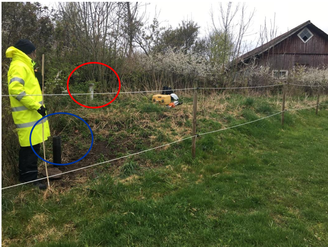
Bild 35 Infiltration. Blå inringning = grundvattenrör. Röd inringning = luftare.
