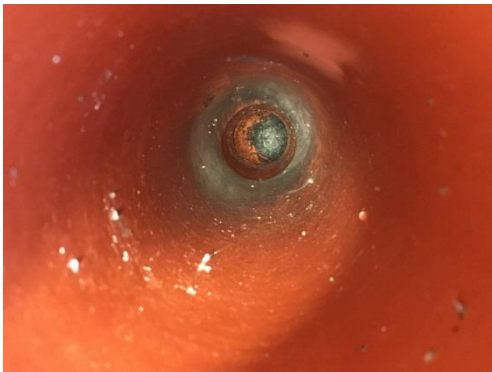
Bild 28 Exempel på luftningsrör med slam.
