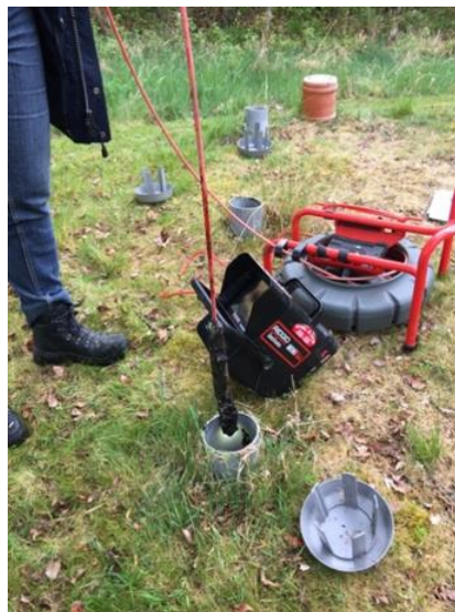
Bild 5 Inspektionskamera med kabel på väg upp från ett luftningsrör på en infiltration.
