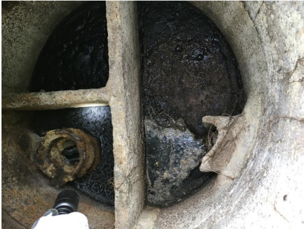
Bild 33 Äldre återanvänd slamavskiljare
