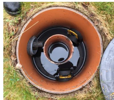
Bild 25-27 Tre exempel på slam i fördelningsbrunn. De två längst till vänster har slam som ligger på ytan och som kan vara en potentiell risk för att komma ut i spridningsledningarna och sätta igen dessa. Fördelningsbrunnen längst till höger har ett kolsvart (förmodligen anaerozt) slam i botten av fördelningsbrunnen.
