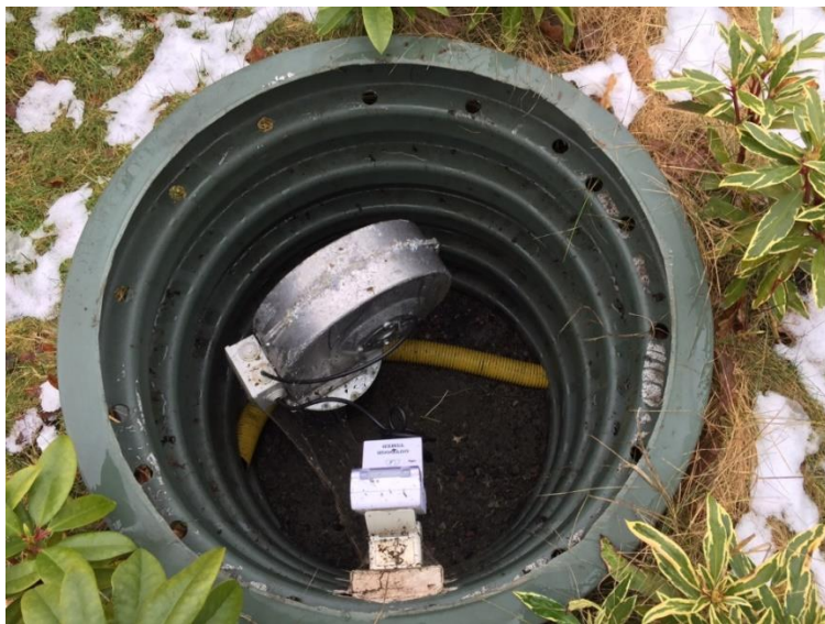
Bild 30 Fläkt med timer i prefabricerad markbädd. Den biologiska processen i bädden är beroende av syretillförseln som styrs genom att fläkten går igång med bestämda tidsintervall.
