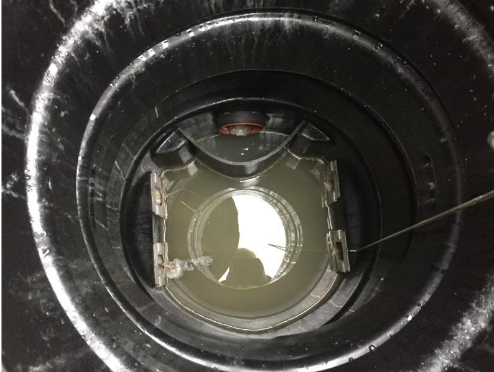
Bild 24 En fördelningsbrunn som bedömdes som normal med jämn fördelning och inget slam.
