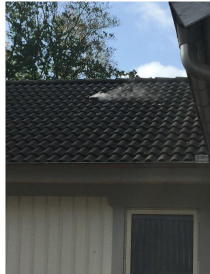
Bild 19-20 Avluftningen kan se olika ut beroende på husets ålder. Till vänster avluftning över nock på 60-talshus. Till höger hus byggt på 2000-talet. Avluftaren ligger infälld i taket.
