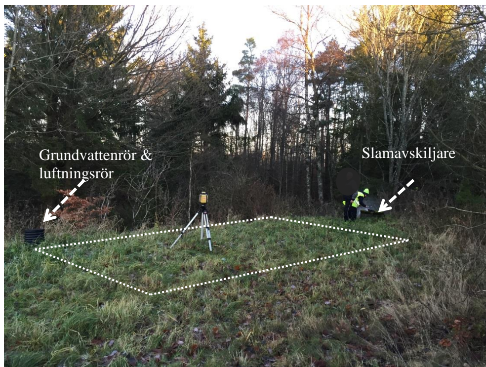
Bild 21 Anläggning nr 18. Den streckade linjen markerar var infiltrationsbädden ligger. Närbild på grundvattenröret
