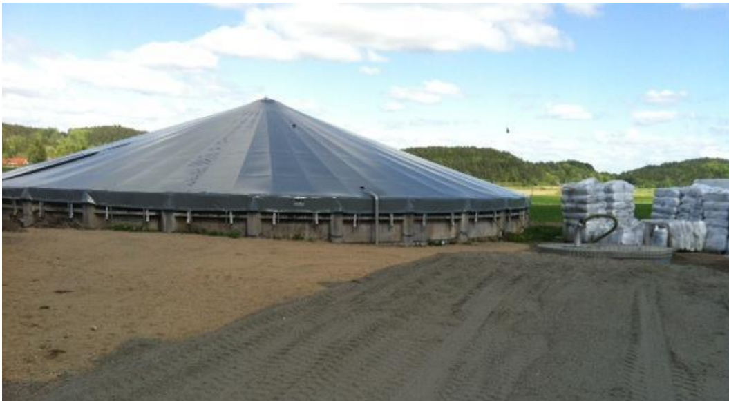
Figur 5. Täckning av gödselbrunn i Uddevalla. Källa bild: från presentation Katarina Bjelke VA-rådgivning med kretsloppsfokus. Nätverksträff, Små avlopp i kretslopp, Uddevalla, 4 oktober 2016.
