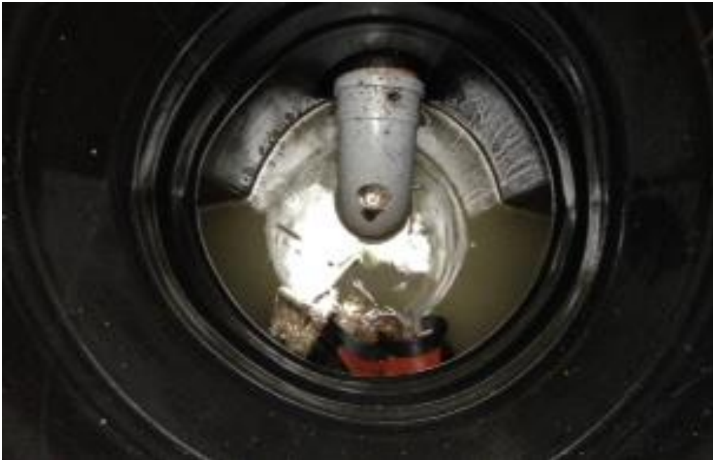
Figur 8. Exempel på fördelningsbrunn som bedömts ha lite flytslam vid inventeringen.
