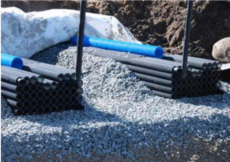
Figur 3. Bädd som byggts upp av biomoduler av typen BIO-BLOK (fotografi: Maria Hübinette).
