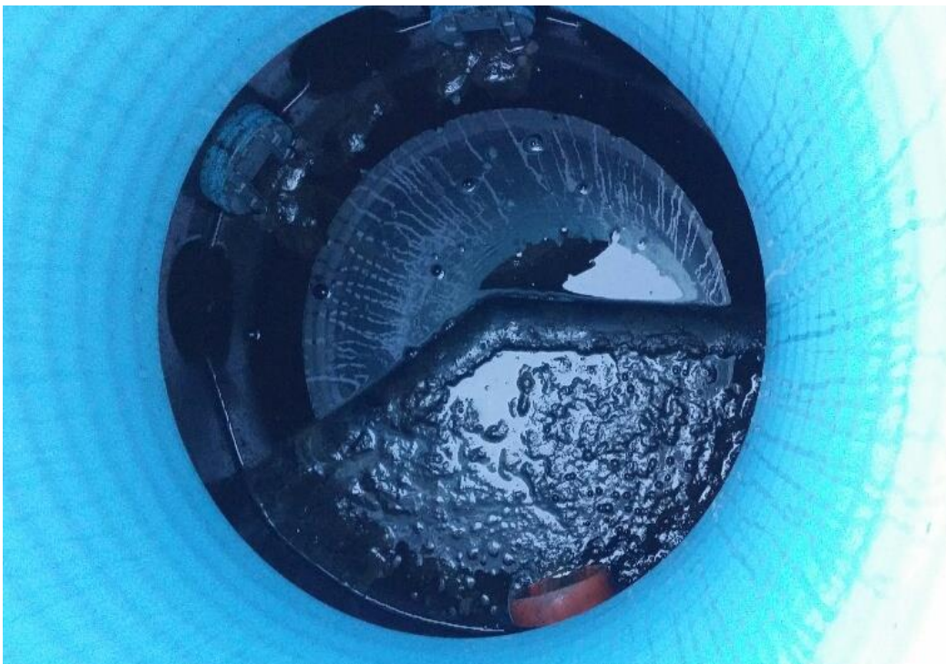
Figur 9. Exempel på fördelningsbrunn som bedömts ha mycket flytslam vid inventeringen.
