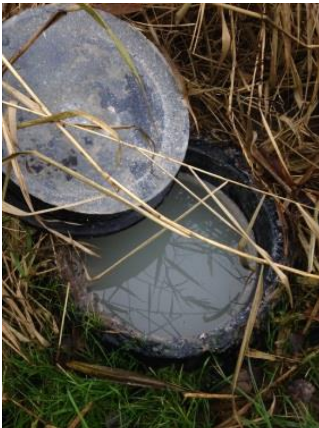
Vattenfylld fördelningsbrunn.
