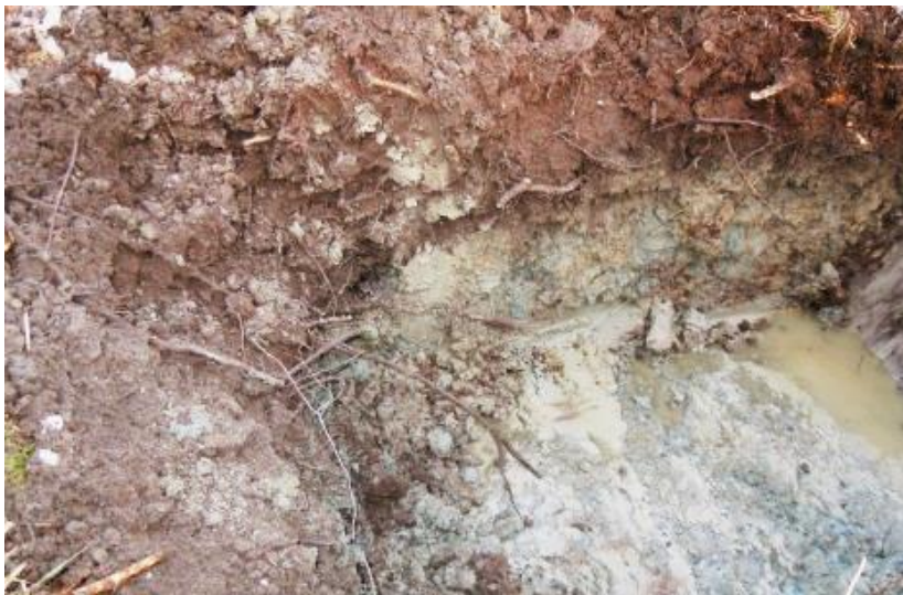
Provgrop vid förnyad inspektion.
