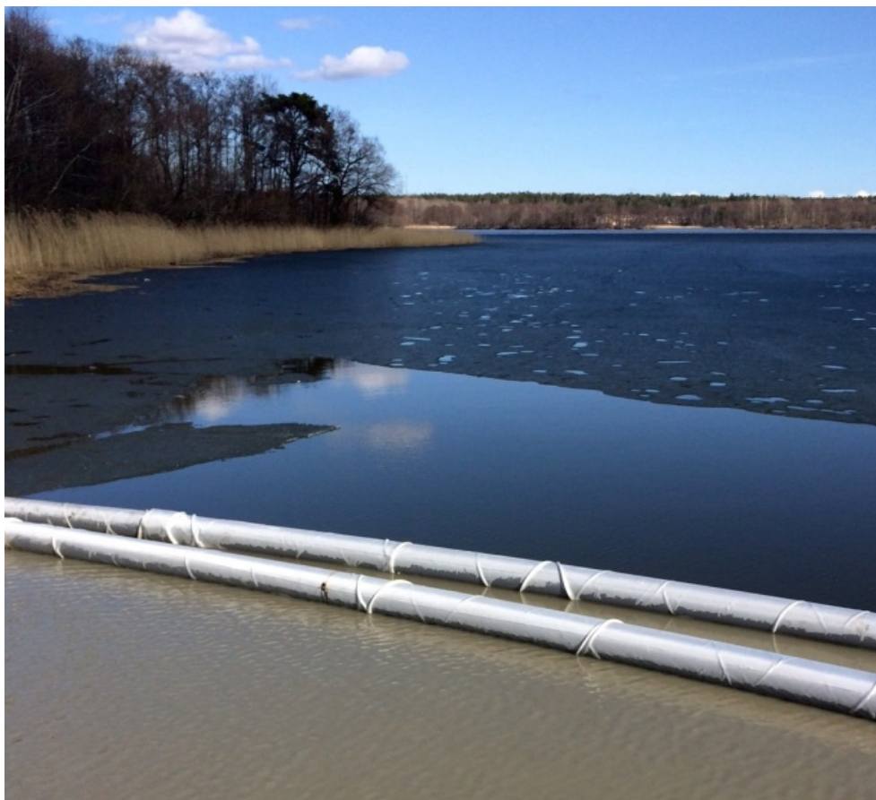
Figur 7. Användande av en geotextil för att förhindra grumling. Foto: Sjuntorp Oljelänsor AB.
