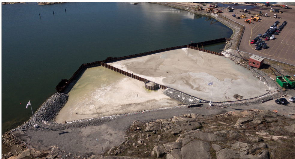
Figur 4. Stabiliserade massor i Göteborgs hamn. Foto: onesight.se.
