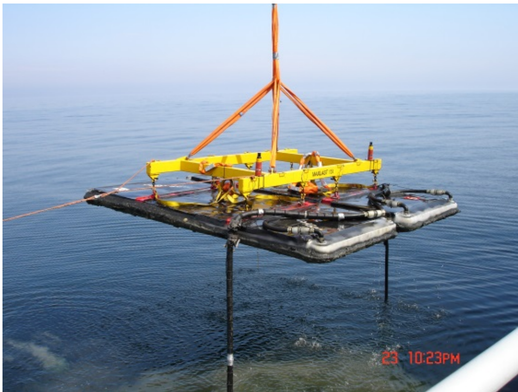
Figur 2. Frysmuddring används vid bärgning av en DC3. Foto: Marcus Höök, WSP.
