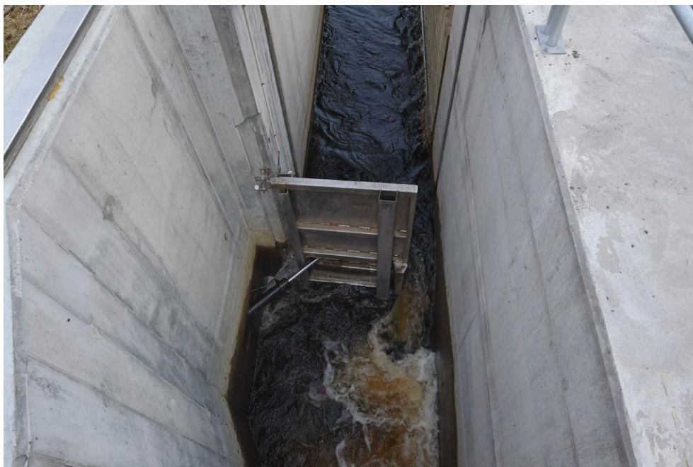
Figur 7. Flyktöppning och klafflucka. Slitsöppningen i luckan är 30 cm bred och 65 cm djup vid normalvattenstånd. Luckan avbördar ca 400 l/s i stängt läge. Foto: Fiskevårdsteknik.
