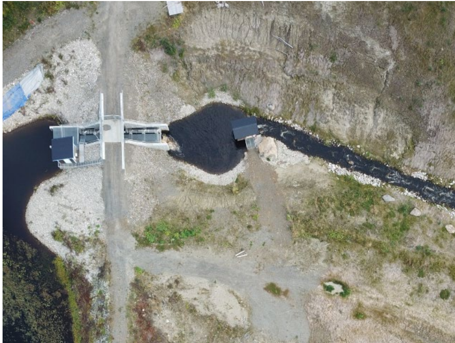
Figur 8. Omlöp som är utformat som en hybrid mellan slitsränna och en naturlig stigränna. De inledande 7 slitsarna möjliggör en jämn flödesregim i omlöpet trots varierande övertvattenyta. Foto: Mattias Olsson, Länsstyrelsen Västernorrlands län.
