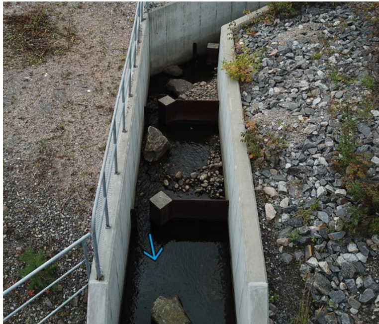
Figur 21. Slitsränna med struktur på botten. Foto: Mattias Olsson, Länsstyrelsen Västernorrland.
