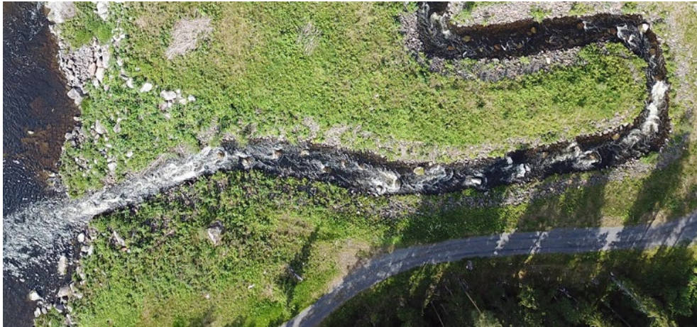
Figur 23. Omlöp utformat som en blockrik bäck. Foto: Mattias Olsson, Länsstyrelsen Västernorrland
