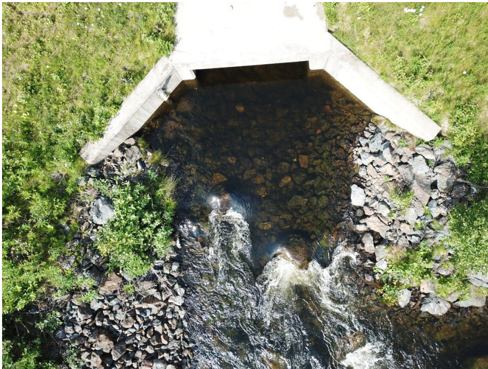
Figur 24. En flödesbestämmande tröskel är placerad bakom utskovet varvid höga vattenhastigheter i omlöpet undviks. Foto: Mattias Olsson, Länsstyrelsen Västernorrlands län.
