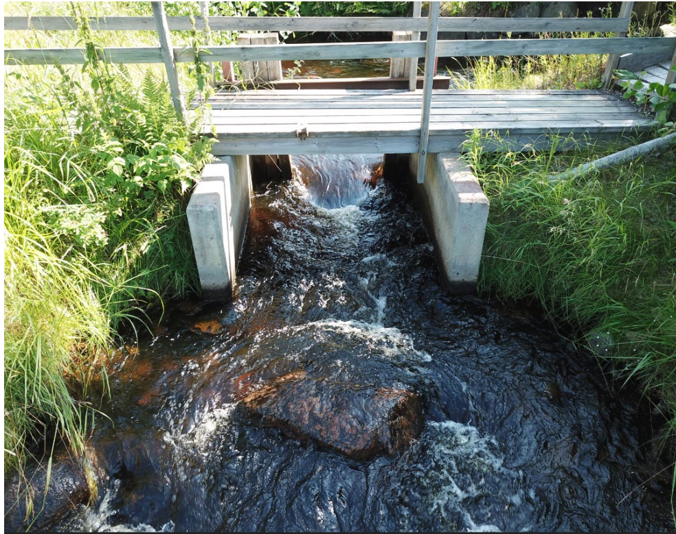
Figur 25. Flödesbestämmande tröskel i form av ett stenblock. Foto: Mattias Olsson, Länsstyrelsen Västernorrlands län.
