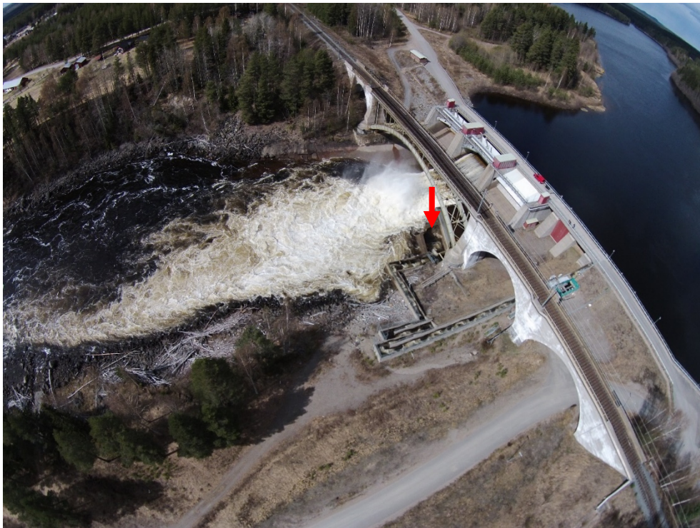
Figur 2. Ingången (röd pil) till fiskpassagen är placerad i ett område som blir mycket turbulent vid högflöden. Foto: Fiskevårdsteknik.
