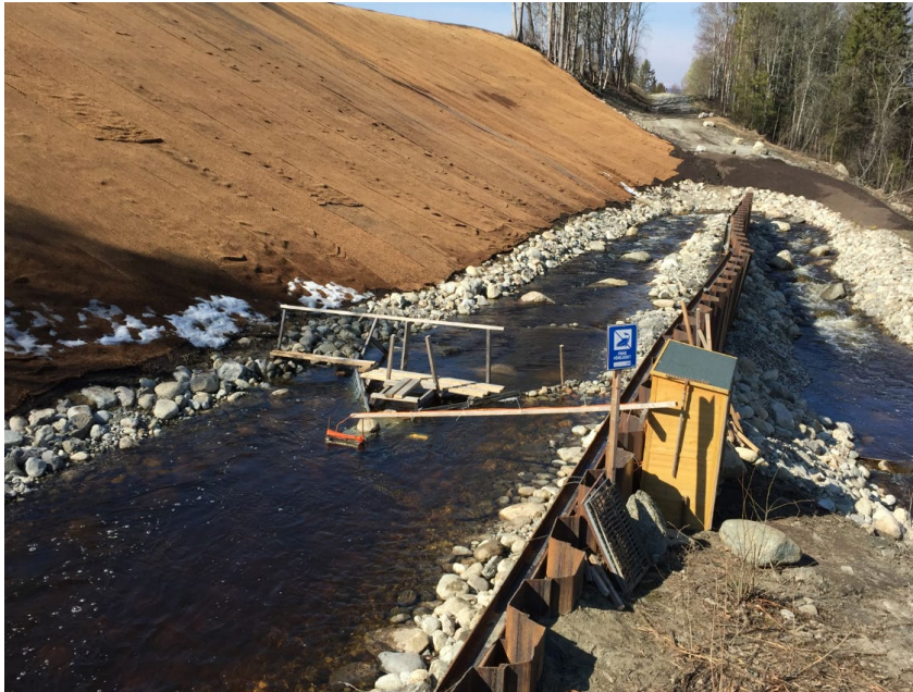
Figur 16. Exempel på schaktslänter vid omlöp. Foto: Länsstyrelsen Jämtland.
