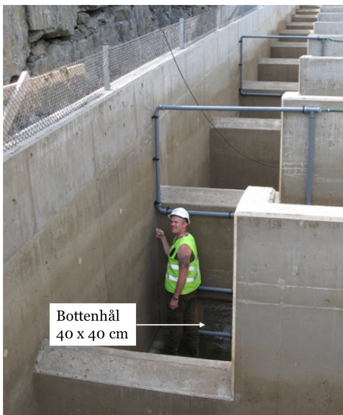
Figur 13. Bassängtrappa med nedsänkning och bottenhål. Foto: Lo Persson.
