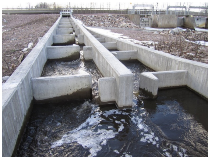
Figur 20. Denna slitsränna avbördar ca 400 l/s med 12 cm fall per slits. Bassängerna är 3,35 m långa och 1,8 m breda. Foto: Fiskevårdsteknik.
