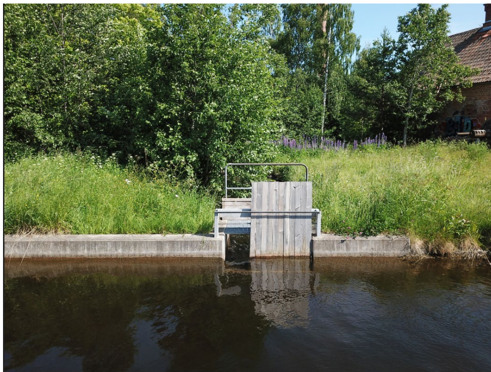
Figur 9. Enkel reglering av inflöde till passage via sätтар. Foto: Mattias Olsson, Länsstyrelsen Västernorrlands län.
