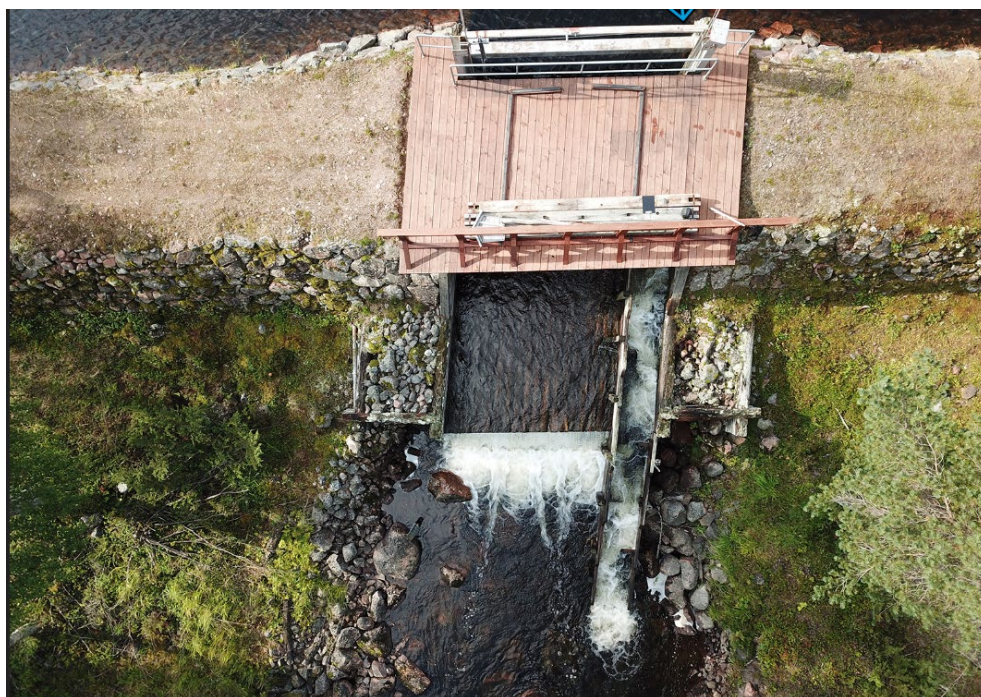
Figur 11. Mynning parallellt med huvudflödet. Foto: Mattias Olsson, Länsstyrelsen Västernorrland.
