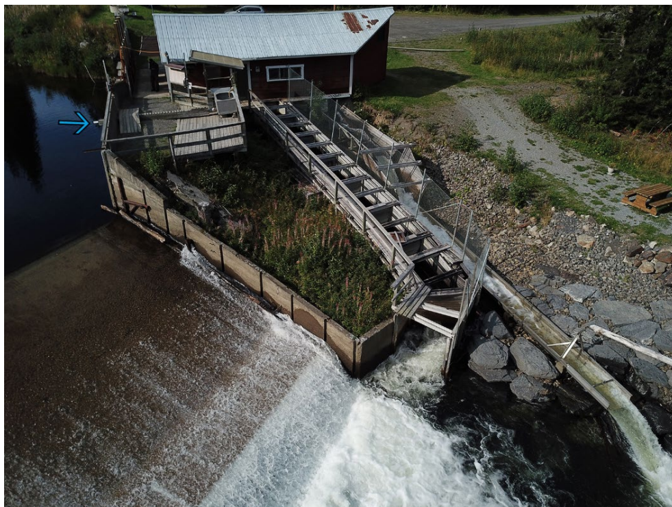
Figur 10. Vinkelrät mynning vilket ger ett kort anlockningsflöde vilket i detta fall förmodligen kan vara svårt för fisken att identifiera givet turbulensen och vattenhastigheten i området utanför mynningen (ingången för uppströmsvandrande fisk). Foto: Mattias Olsson, Länsstyrelsen Västernorrlands län.
