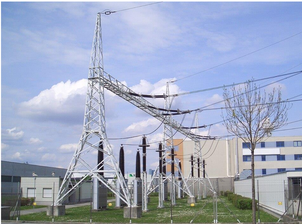
Figur 1: Exempel på terminalstation där luftledning övergår i markkabel (Wdwd, 2020). CC BY-SA 3.0
