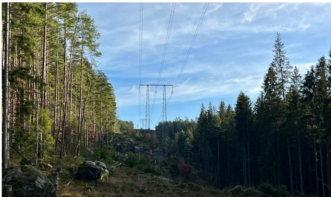
Figur 7: Exempel på kraftledningsgata för luftledning med röjd skogsgata (AFRY).
