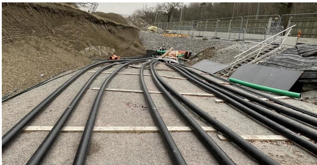
Figur 11: Öppet schakt vid förläggning av HVAC-kablar i horisontell formation (AFRY).
