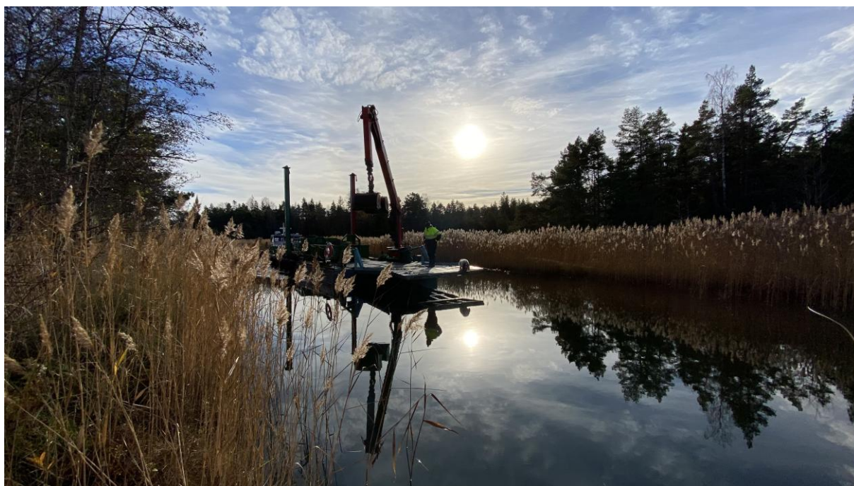
Anläggning av erosionsskydd i mynningen till en grund havsvik på Gräsö. Foto: Linda Kumblad, projektet Levande vikar
