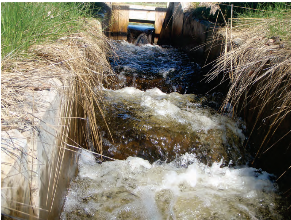
Figur 32. Övre fotot visar del av omlöpet samt regleranordningen. Det nedre fotot visar regleranordningens bassängliknande konstruktion.
