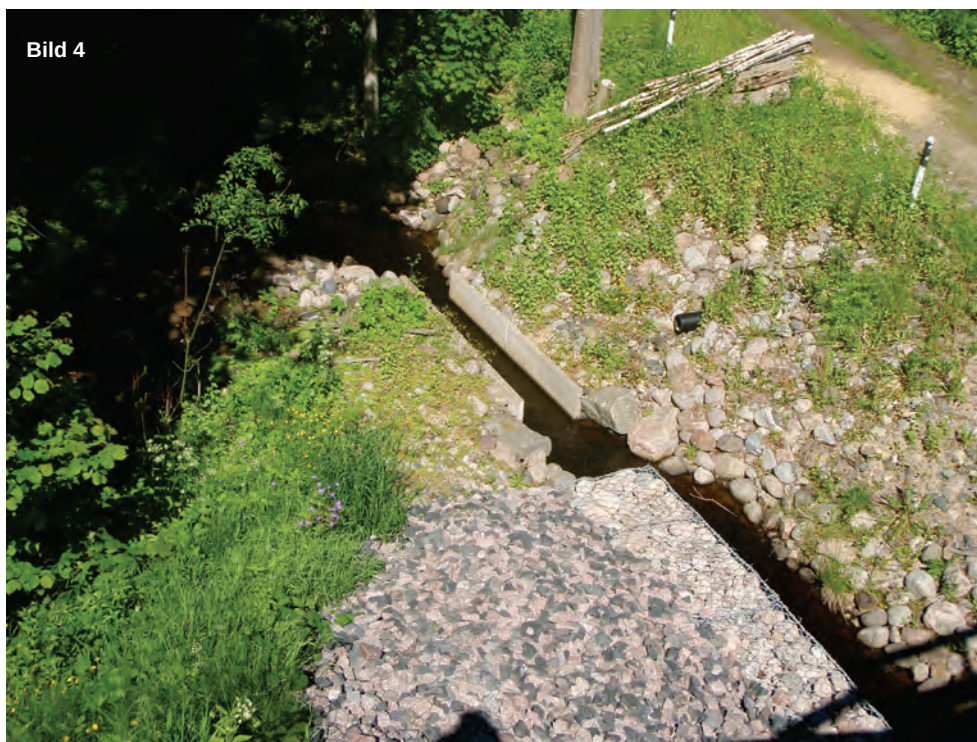
Figur 13. Olika regleringsalternativ. Bild 1 visar reglering med spettlucka och sättar i Västerån, Skogsfors, Jönköpings län. Bild 2 visar V-format utskov med överliggande sättar för att begränsa flödet vid högvatten från Jälmån, Nyfors, Västra Götalands län. Bild 3 visar trumma som begränsar flödet i Almaån, regleringsdammen vid Finjasjön, Skåne län. Bild 4 visar öppet, självreglerande, inlopp i betongvagg i Skämningsforsån, RV 195, Jönköpings län.
