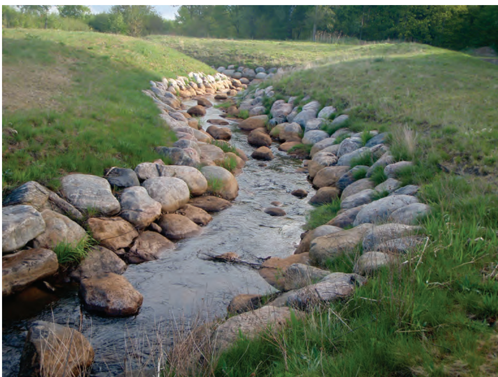
Figur 33. Övre fotot visar omlöpets utlopp nedan vandringshindret. Det nedre fotot visar omlöpets konstruktion.
