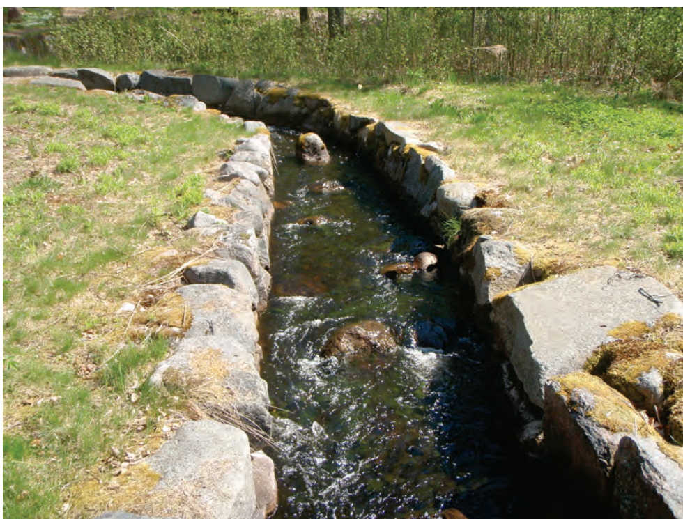
Figur 29. Övre fotot visar regleranordningen med spettlucka. Det nedre fotot visar del av omlöpet.
