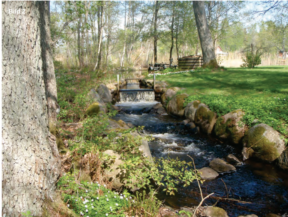
Figur 11. Exempel på olika problemställningar. Bild 1 visar en svår passage i ett omlöp. Tämmligen högt fall tillsammans med begränsade möjligheter för fiskens avsats. Bild 2 visar en reglering med hög nivåskillnad mellan övre och nedre vattenytan.
