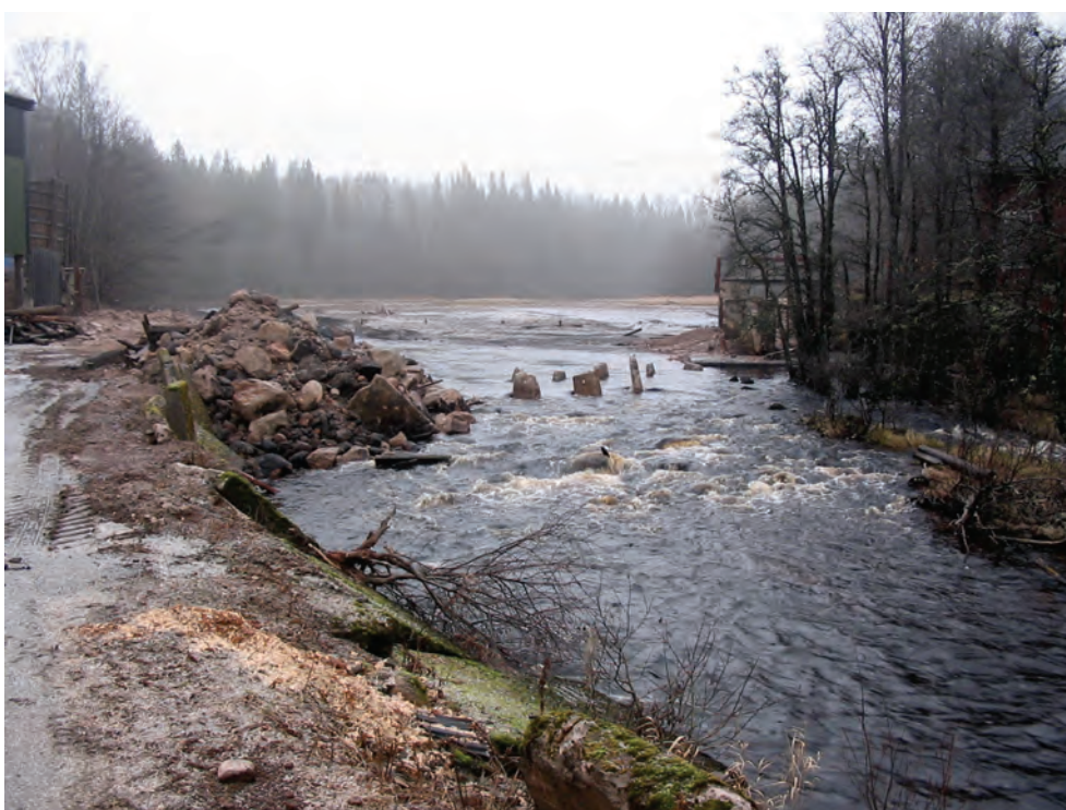
Figur 23. Övre fotot dammen före utrivning. Det nedre fotot visar dammen utskov efter utrivning. Foto: Per Sjöstrand, Jönköpings Fiskeribiologi.
