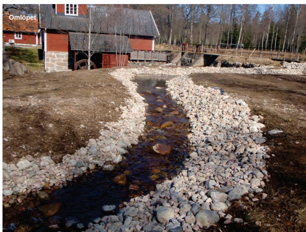
Figur 5. Foton tagna i samband med byggnation av omlöp vid Stocke kvarn, Rottneån, Kronobergs län. Observera gummiduken som används för att minimera risken för infiltration i marken.
