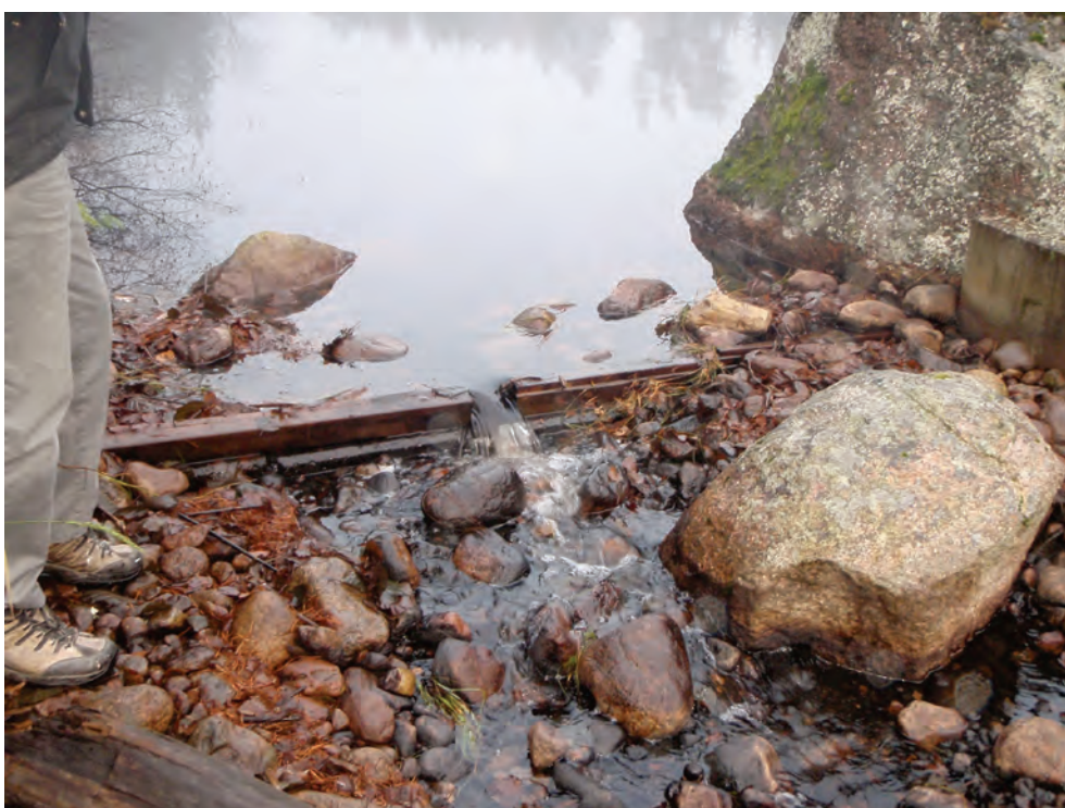
Figur 44. Övre fotot visar del av inlöpets spontning. Nedre fotot visar reglering i inlöpets inlopp.
