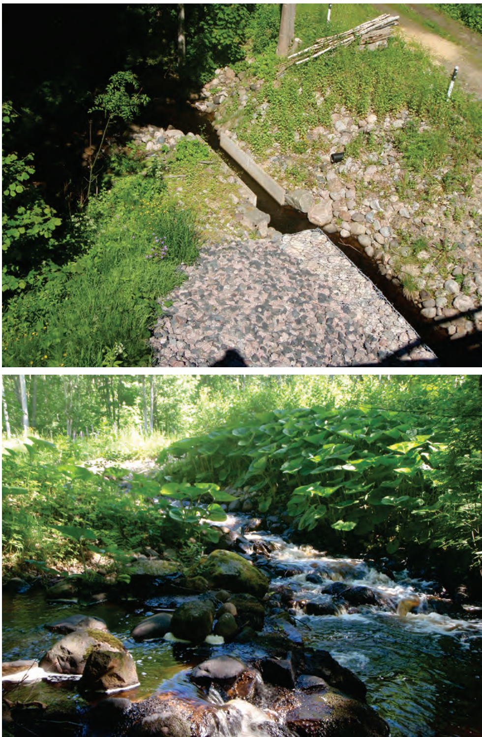
Figur 18. Övre fotot visar inloppet med betongförstärkta kanter. Det nedre fotot visar omlöpets utlopp i huvudfåran.
