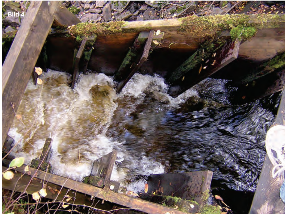
Figur 3. Exempel på olika fiskvägsmodeller. Bild 1 visar ett naturliknande omlöp vid Fågelfors i Nötån, Kalmar län. Bild 2 visar ett naturliknande inlöp vid Hemsjö nedre i Mörrumsån (Foto: Arne Johlander), Blekinge län. Bild 3 visar en bassängtrappa med överfall i Lunkbäcken, Kronobergs län. Bild 4 visar en denilränna i Valån, Jönköpings län.
