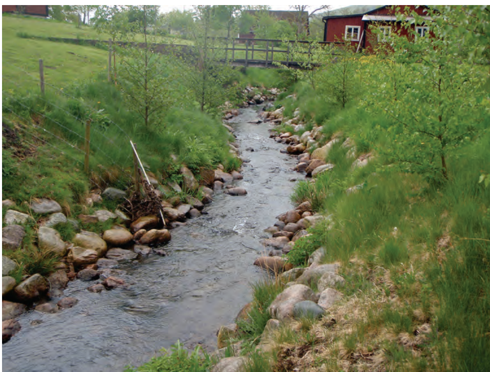
Figur 35. Båda fotona visar delar av omlöpets uppbyggnad.
