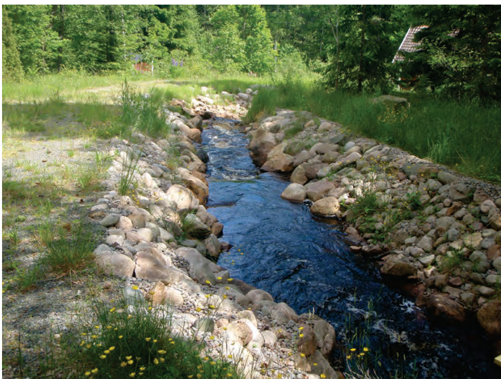
Figur 21. Vänstra fotot visar inloppet till omlöpet med betongförstärkta kanter och enkel reglering. Det högra fotot visar övre delen av omlöpet.
