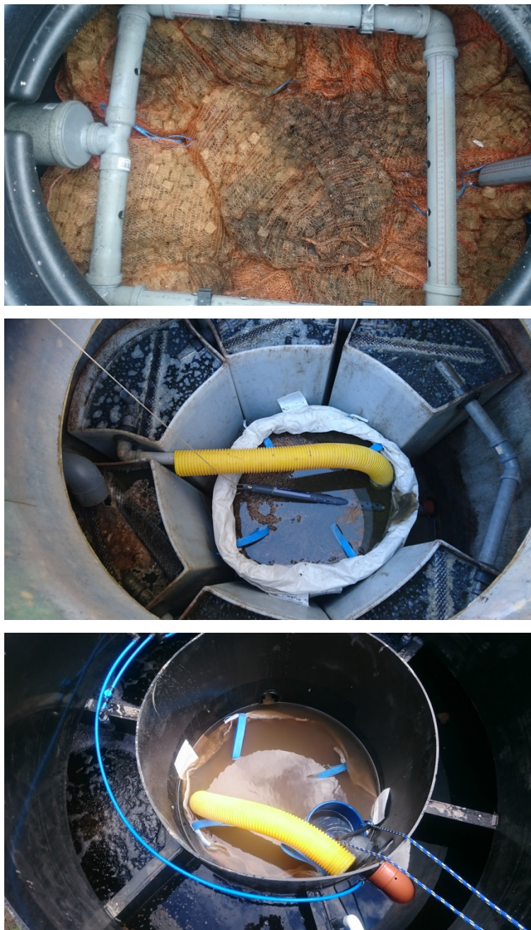
Figur 2. Markbädd på burk i anläggning I (a), Biop® anläggningar J och K (b) och Ecoboxen i anläggning L (c).
