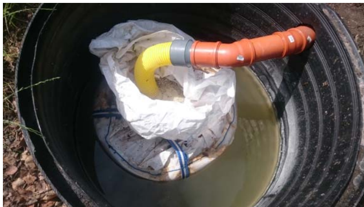
Figur 3. Fosforfilter med Polonitsäck i brunn.
