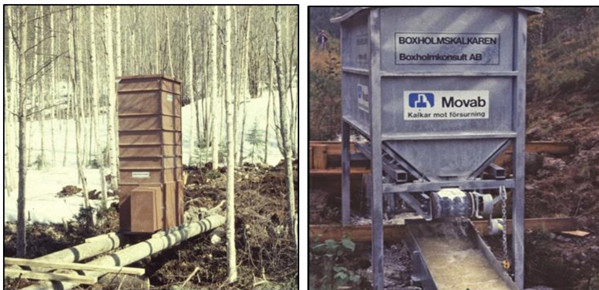
Äldre kalkdoserare drevs ofta av batterier eller via vattenkraft. De saknade automatisk reglering av kalkutmatningen och fylldes vanligen för hand från kalksäckar. Foto: Länsstyrelsen Västerbotten.
