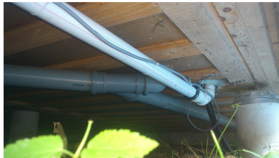
Ledningsdragning krypgrund.
