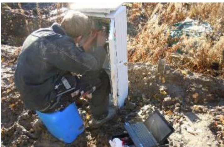
Bild 4 Driftsättning av minireningsverk. Hur driftsättningen ska gå till bör vara redovisat i en installationsanvisning som är bifogad ansökan. Foto: Kungsbacka kommun
