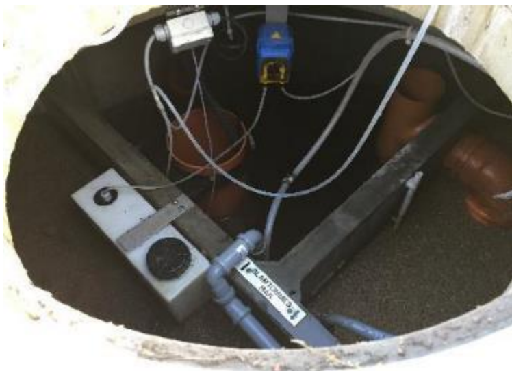
Bild 6 Minireningsverk i drift. Slamsugning är viktig för anläggningens funktion och en drift- och underhållsinstruktion bör innehålla instruktioner för hur detta ska ske. I detta fall finns även en tydlig instruktion på plats i anläggningen för att säkerställa att det blir korrekt slamtömt. Foto: Kungsbacka kommun
