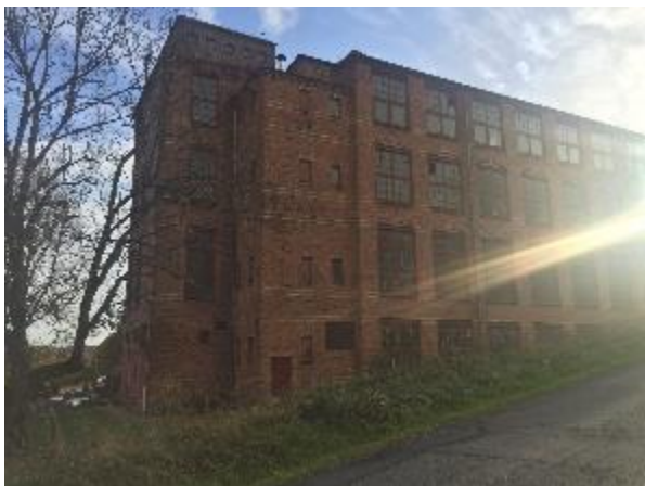
Bild 31. Gammal industrimark kan vara förorenad. Grävning för avloppsanläggning i ett sådant område riskerar att sprida föroreningarna. Foto: Bodil Forsberg
