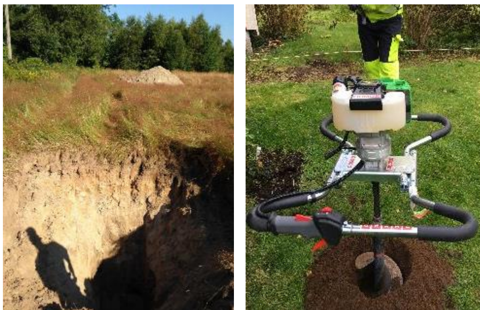
Bild 14 Provgropar grävda med grävmaskin respektive med jordborr. I båda fallen behöver de vara så djupa att man helst kan lokalisera läget för såväl grundvattennivån som berggrundsytan. Ligger både grundvattenyta och berggrund djupt bör 2,5 m räcka. Foto till vänster: Kungsbacka kommun Till höger: Charlotta Larsson
