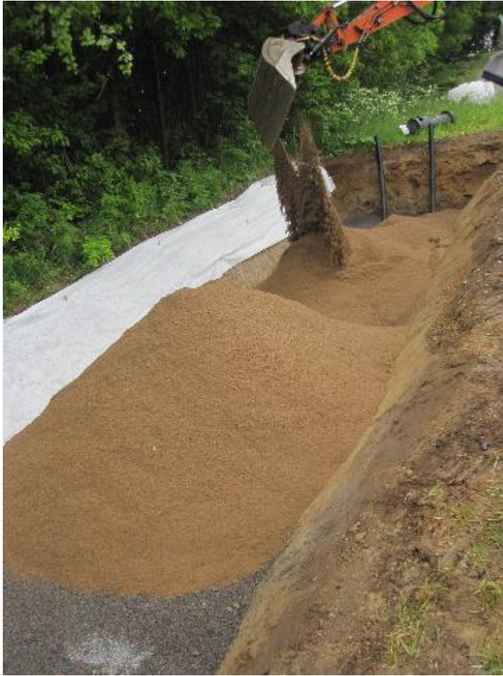
Bild 34. Små avloppsanläggningar är i hög grad beroende av korrekt installation för sin funktion. Ett utförandeintyg med kontrollplan som kopplas till tillståndsbeslutet uppmärksammar entreprenör och fastighetsägare på de viktigaste kritiska momenten i anläggningsarbetet. Foto: Kungsbacka kommun
