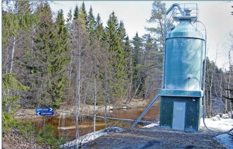
En doserare anpassar utmatningen av kalk efter flödet i vattendraget. Foto: Mats Norberg.
