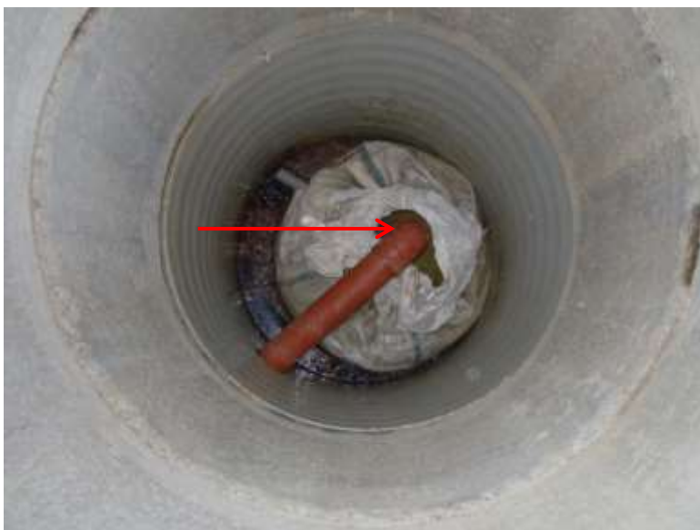
Bild 9 Felinstallerad säck. Modell 1.0 kopplad som modell 1.1.
