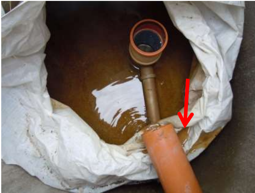
Bild 12 Säcken något felplacerad i brunnen, för kort rör eller säck ej uppviktt ordentligt? Resulterar i att en del vatten hamnar utanför filtret.
