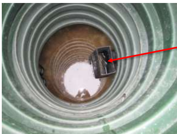
Bild 3 Provtagningspunkt på fosforfälla med lös filtermassa
