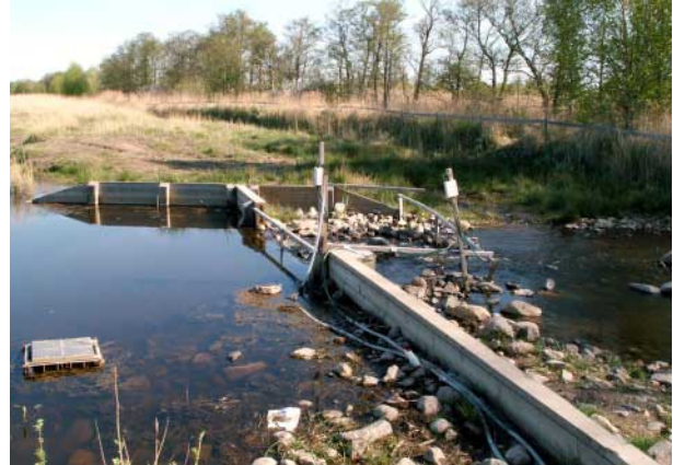
Figur 11. Utloppet i Kalmar dämme efter restaureringsåtgärden (foto: Jonas Nilsson).
