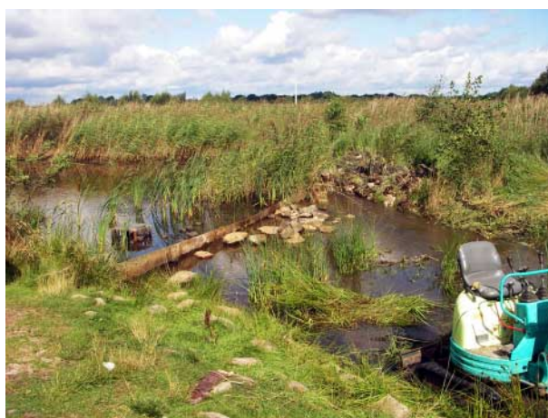
Figur 9. Utloppet i Kalmar däme innan restaureringsåtgärden (foto: Olof Engstedt).
