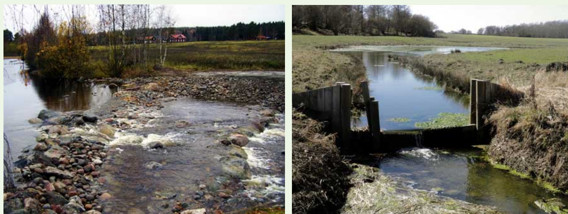
Figur 39. Exempel på naturligt och robust utformat utlopp (vänster), och ett felkonstruerat (höger). Den vänstra bilden är tagen från Skärjåns vattensystem där en äldre damm rivits ut för att skapa fri vandringsväg. En forsacke har anlagts för att behålla en vattenspiegel uppströms. Nackens utformning är designad för att vattenytan uppströms inte ska stiga alltför mycket vid höga flöden, därav dess bredd. Vid låga flöden koncentreras flödet till ett smalare parti som koncentrerar flödet. Utformningen på nacken (tvärsnittsytan) styr hur vattenståndet uppströms kommer att förändras beroende på flöde. Foto: Jan Lundstedt, vänstra bilden. Jonas Nilsson, högra bilden.
